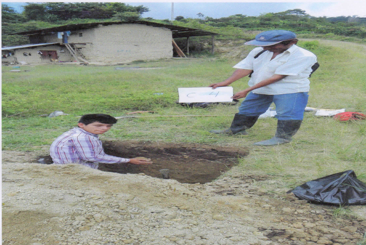
VISTA DE LA CALICATA N° 04 – RED DE DISTRIBUCION
