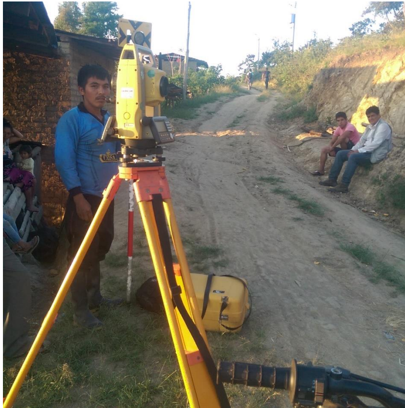
Realizando el estudio topográfico de la localidad del Cruce
