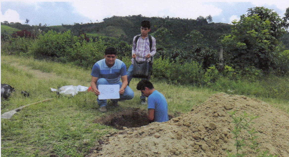
VISTA DE LA CALICATA N° 03 – RESERVORIO
