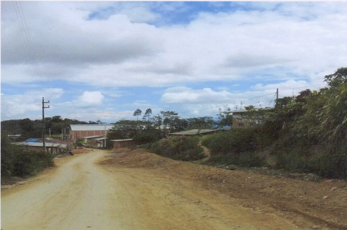
VISTA PANORAMICA DEL PROYECTO: DISEÑO DEL SISTEMA DE AGUA POTABLE PARA LA LOCALIDAD EL CRUCE, DISTRITO CHIRINOS PROVINCIA SAN IGNACIO – REGION CAJAMARCA
