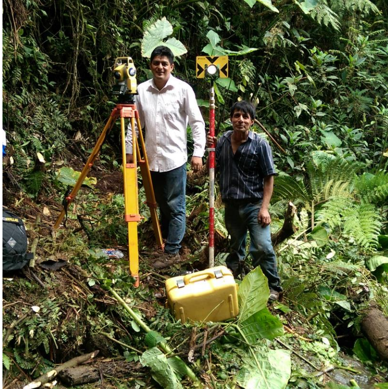
Iniciando los trabajos de topografía
