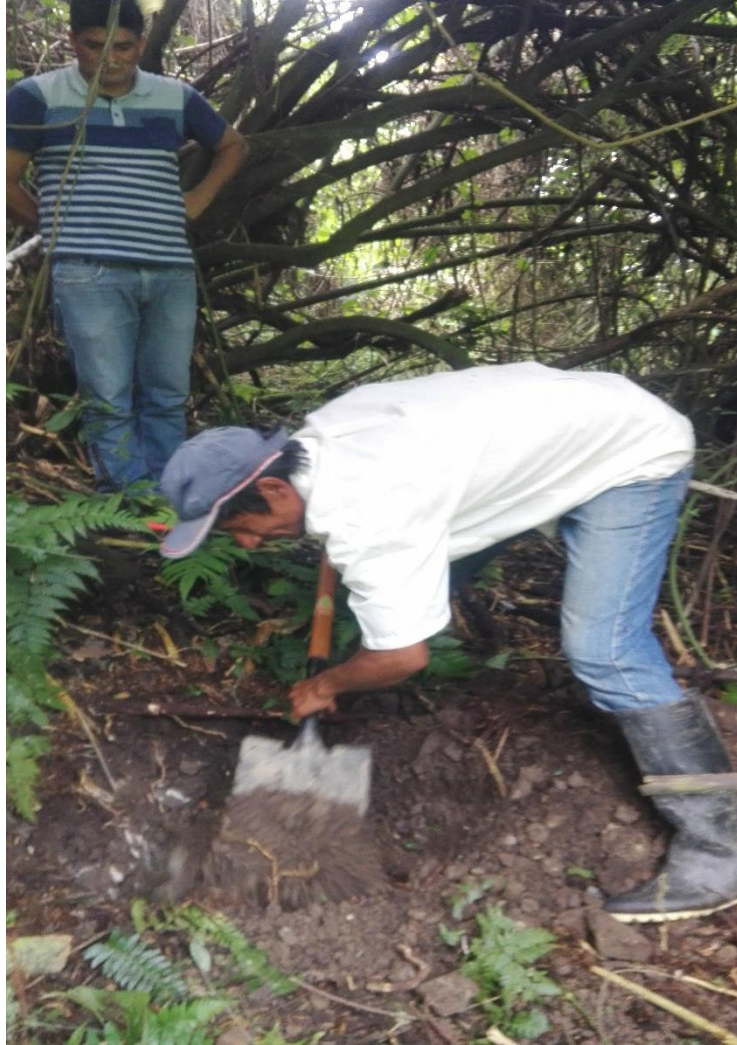
Realizando la excavación para calicatas, calicata de captación
