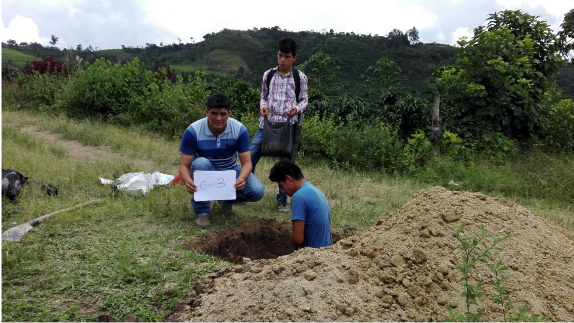
Calicata N° 03, en reservorio
