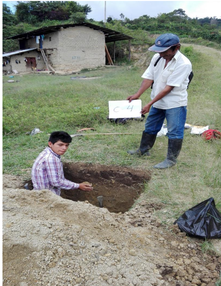
Calicata N° 04, línea de distribución
