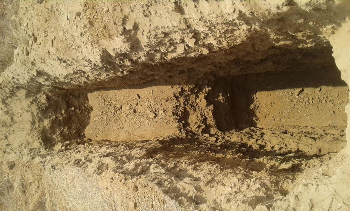
Anexo N° 4: Calicata N° 3
