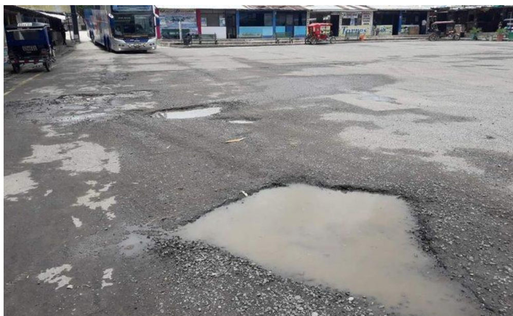
Figura 43: Estado actual del terminal terrestre de Moyobamba, parte interna
