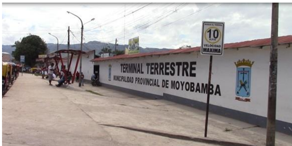
Figura 42: Estado actual del terminal terrestre de Moyobamba, ingreso principal
