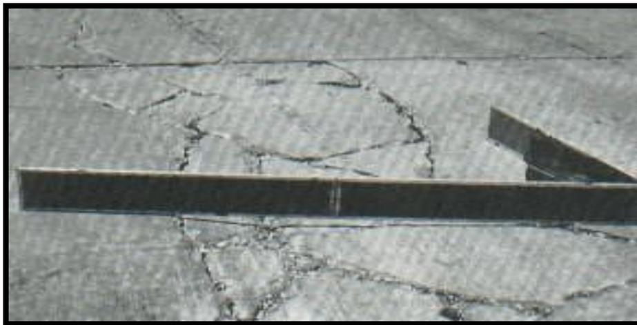
**Figura 14: Punzonamiento de alta severidad.**
