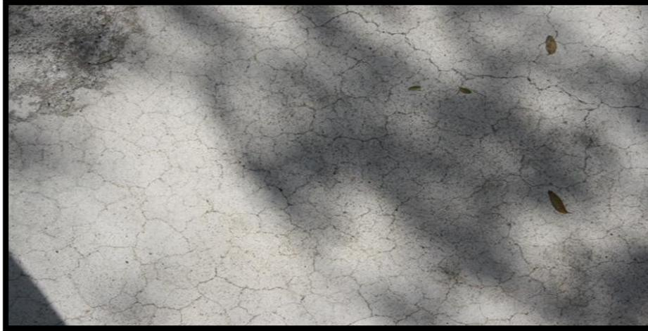
**Figura 4: Grieta de durabilidad de alta severidad.**
