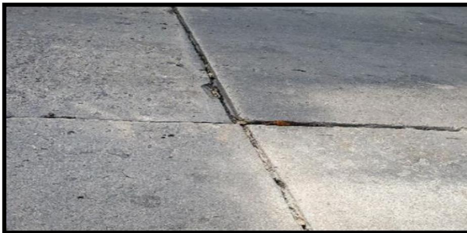
**Figura 5: Escala de Severidad media.**
