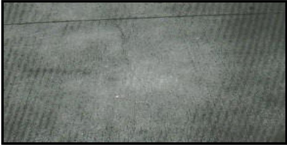
**Figura 17: Grietas de retracción.**
