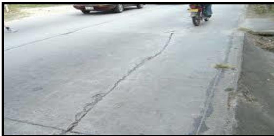
**Figura 3: Losa dividida de severidad media.**
