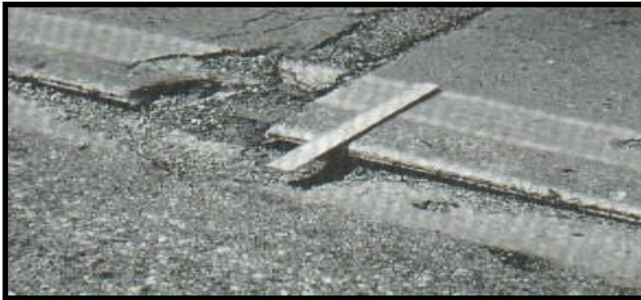
**Figura 7: Desnivel carril / berma de baja severidad**
