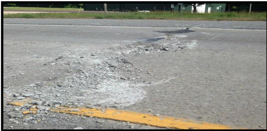
**Figura 1: Blowup / Buckling de baja severidad.**
