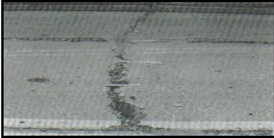
**Figura 8: Grietas lineales de alta severidad en losa de concreto simple.**
