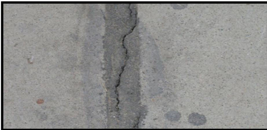
**Figura 6: Daño del sello de junta de baja severidad**
