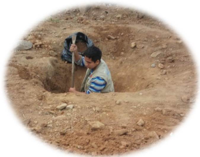
REALIZACIÓN DE CALICATA
