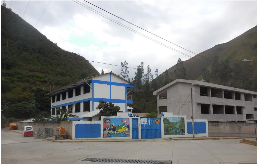
EN LA IMAGEN SE PUEDE APRECIAR LAS MODERNAS INSTALACIONES EXTERIORES DE LA INSTITUCIÓN EDUCATIVA DE LA LOCALIDAD (COLEGIO URIEL GARCIA - STA TERESA)
