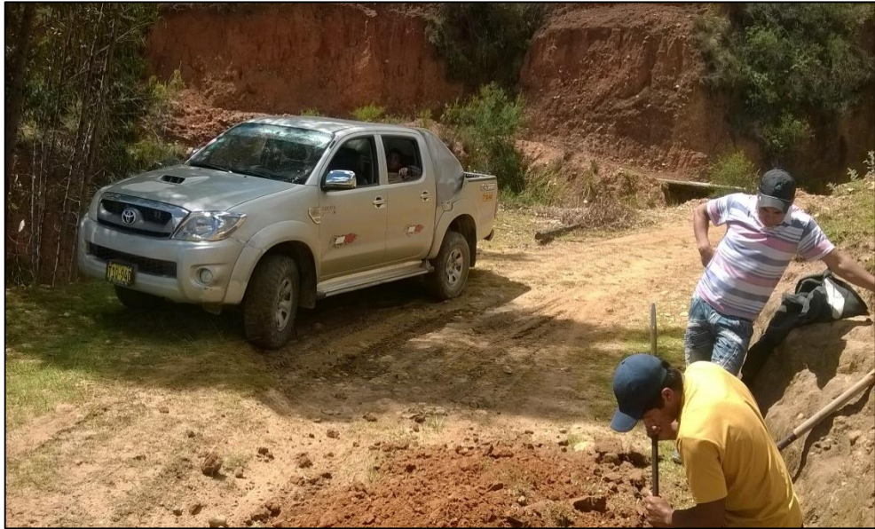
Exploración de la calicata 2
