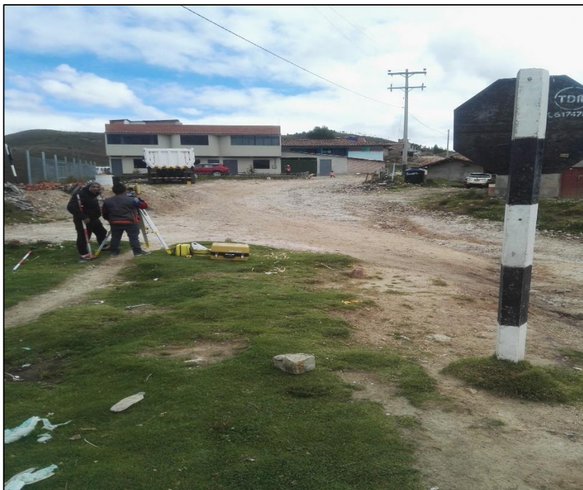
Punto de inicio en los trabajos de topografía
