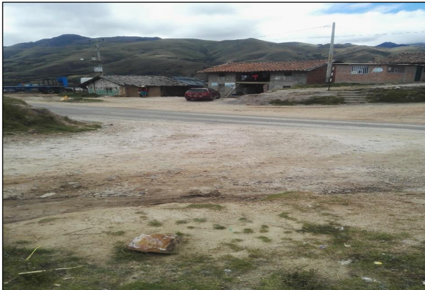
Punto de inicio del tramo caserío La Arena
