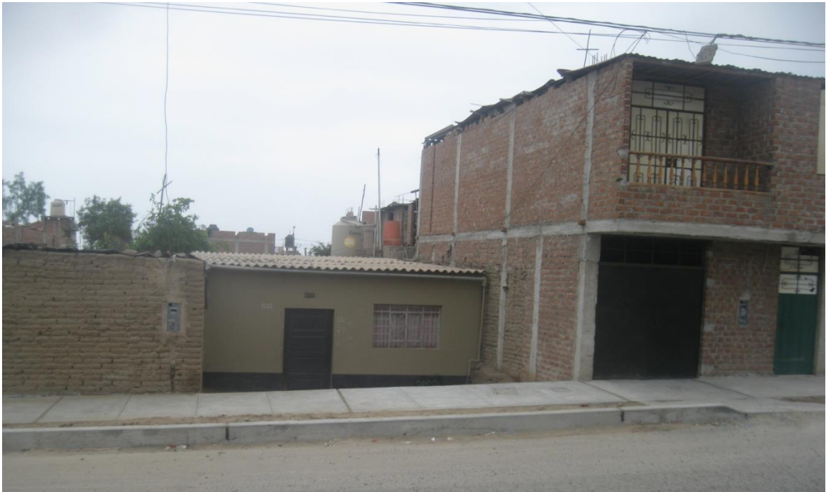
FOTO 03: VIVIENDAS CON DIFERENTES NIVELES DE PISO
