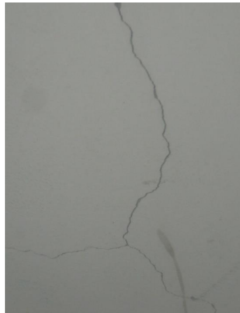
FOTO 28: FISURAS EN MUROS PRIMER PISO POR ASENTAMIENTO DEL SUELO
