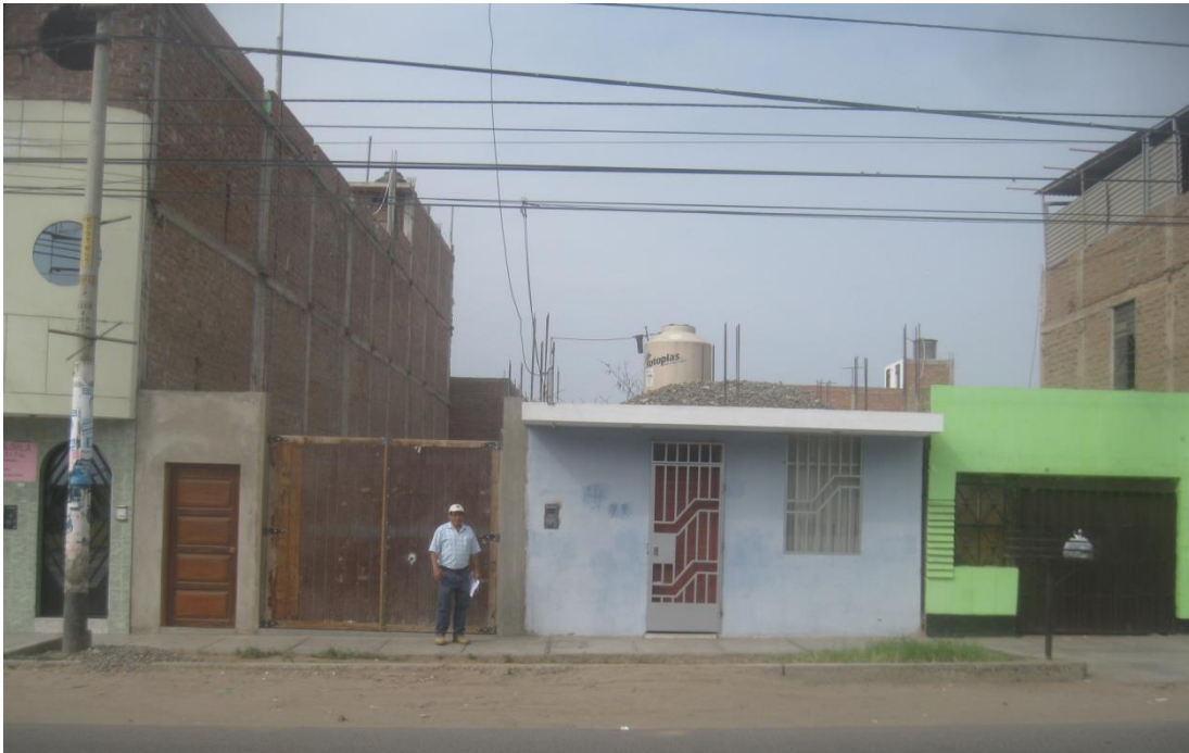
FOTO 07: FIERRO EXPUESTO DE COLUMNAS EN ZONA DE TRASLAPE
