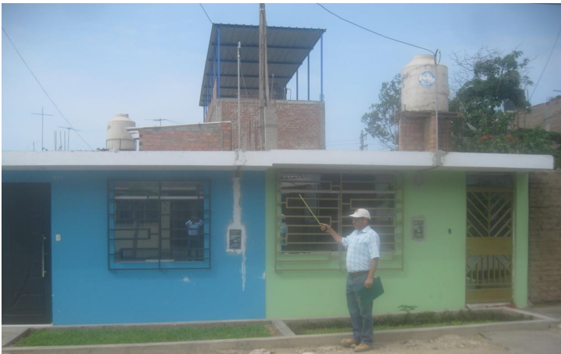
FOTO 20: VIVIENDAS DE TECHO PROPIO SIN JUNTA DE DILATACIÓN
