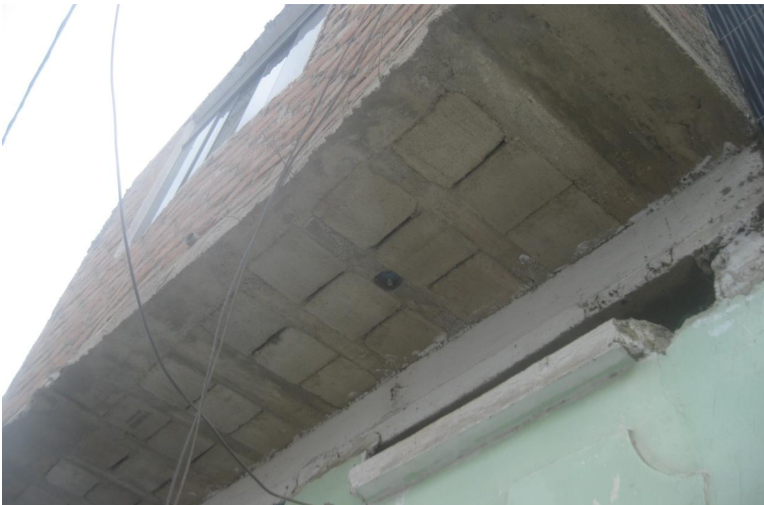
FOTO 10: CENTRO DE LUZ EN ZONA DE VIGUETAS
