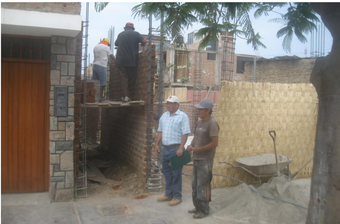
FOTO 14: MANO DE OBRA - CONSTRUCCION DE VIVIENDAS DE ALBAÑILERIA
