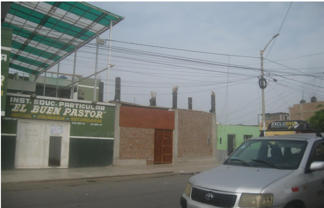
FOTO 08: VIVIENDA CON COLUMNAS PROTEGIDAS - TRASLAPES
