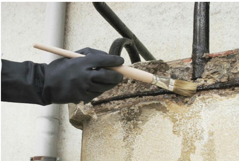
Imagen 4.2. : Protección acero en columnas
