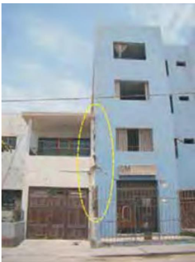
Imagen 1.6 : Juntas de dilatación
