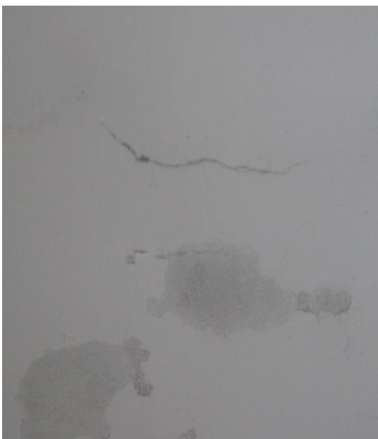
FOTO 28: FISURAS EN MUROS PRIMER PISO POR ASENTAMIENTO DEL SUELO
