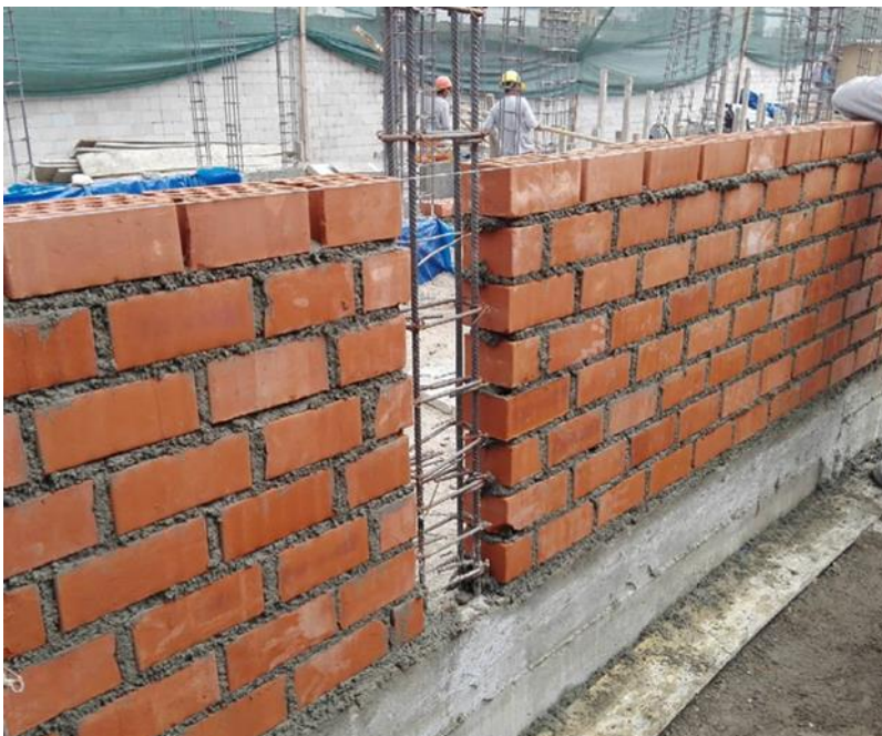
FOTO 16: ASENTADO DE LADRILLO KK 18H. MUROS DE SOGA
