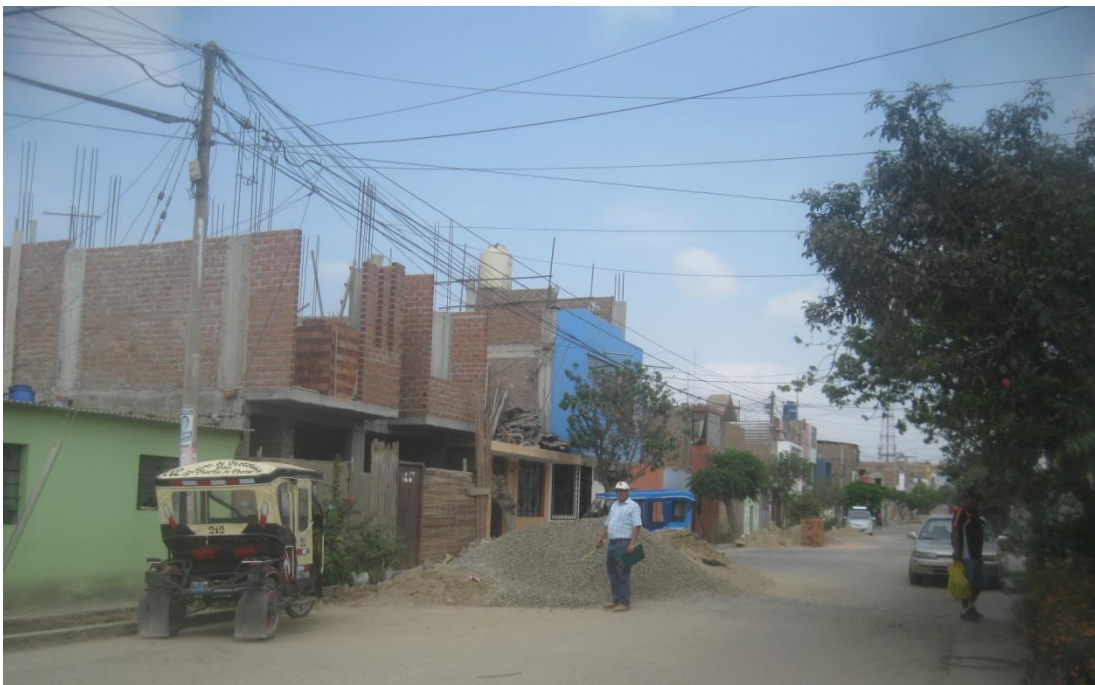
FOTO 18: AGREGADOS PARA OBRA EN VIA PÚBLICA
