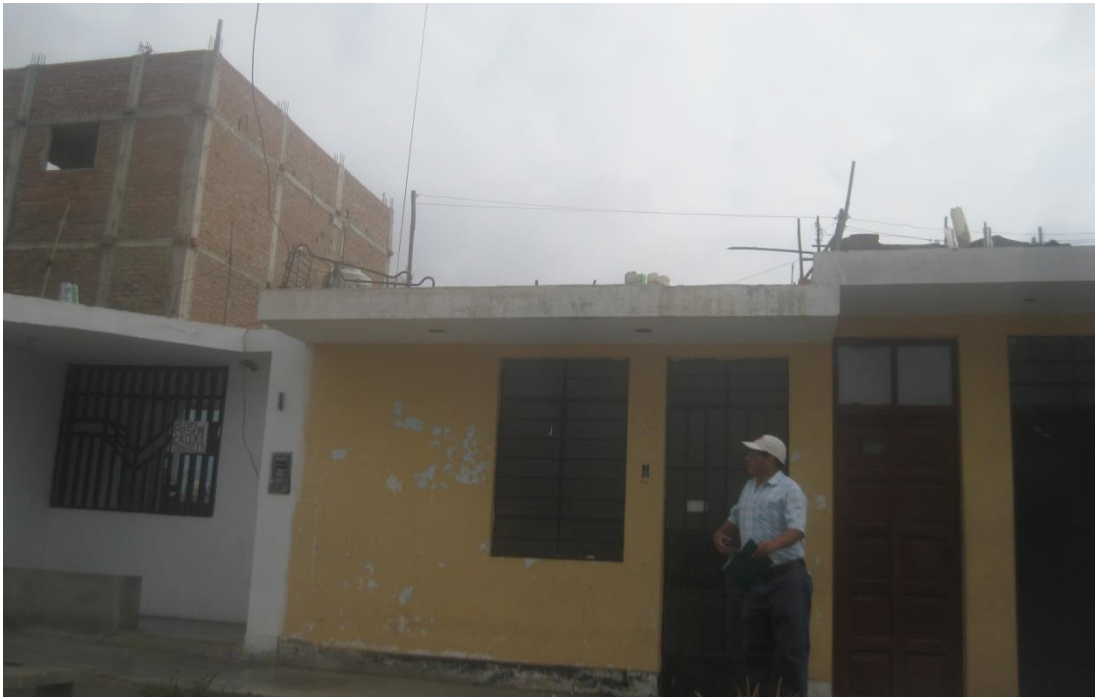
FOTO 11: VIVIENDAS TIPICAS DE TECHO PROPIO
