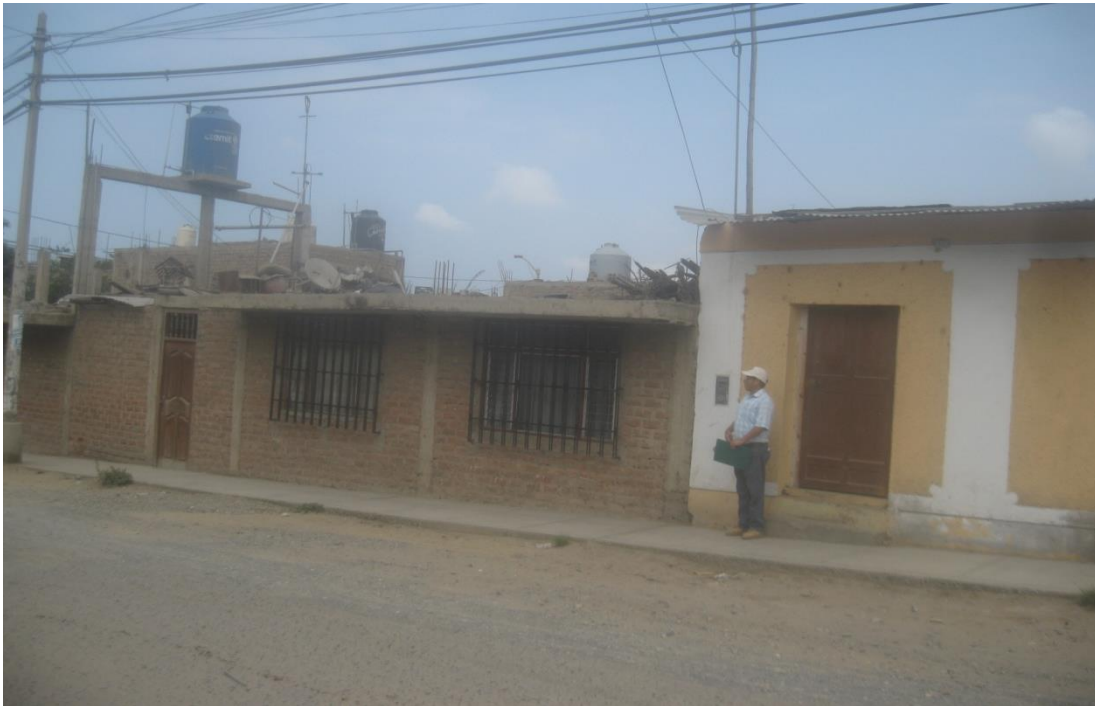
FOTO 17: TECHOS DE VIVIENDAS CON MATERIAL ACUMULADO
