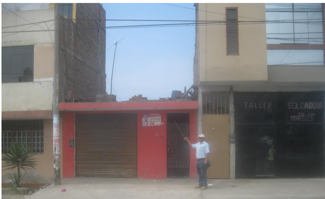
FOTO 22: FALTA DE LIMPIEZA DE TECHOS DE VIVIENDAS
