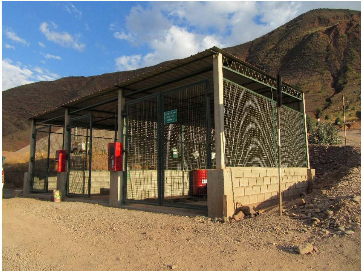
Figura. 37 Vista almacén de aceites
