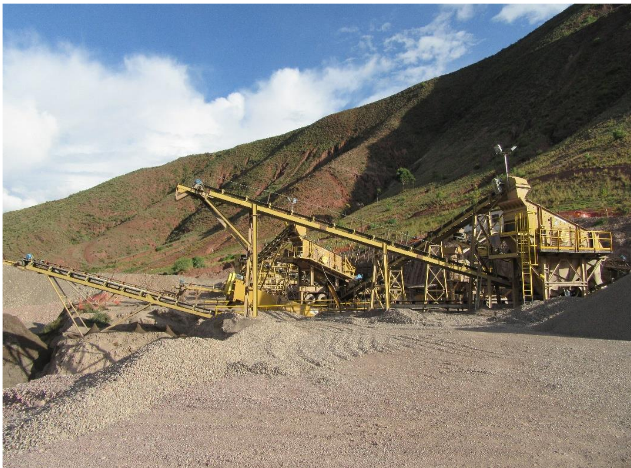
Figura. 33 Vista de las pilas de producción de la chancadora TRIO
