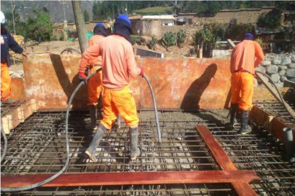
Imagen 53.Vibrado del concreto.
