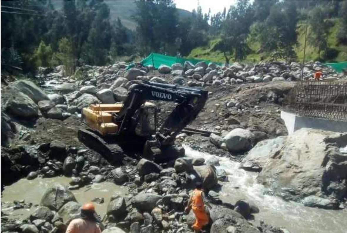
Imagen 33. Falta de accesos delimitados, y falta de uso de Epp.
