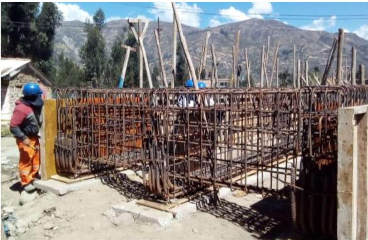
Imagen 40. Espacios estrechos para encofrar viga
