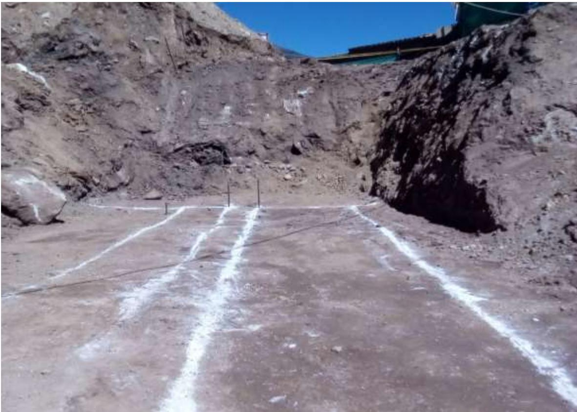
Imagen 62 Trazo y replanteo para zapatas de muro de contención.
