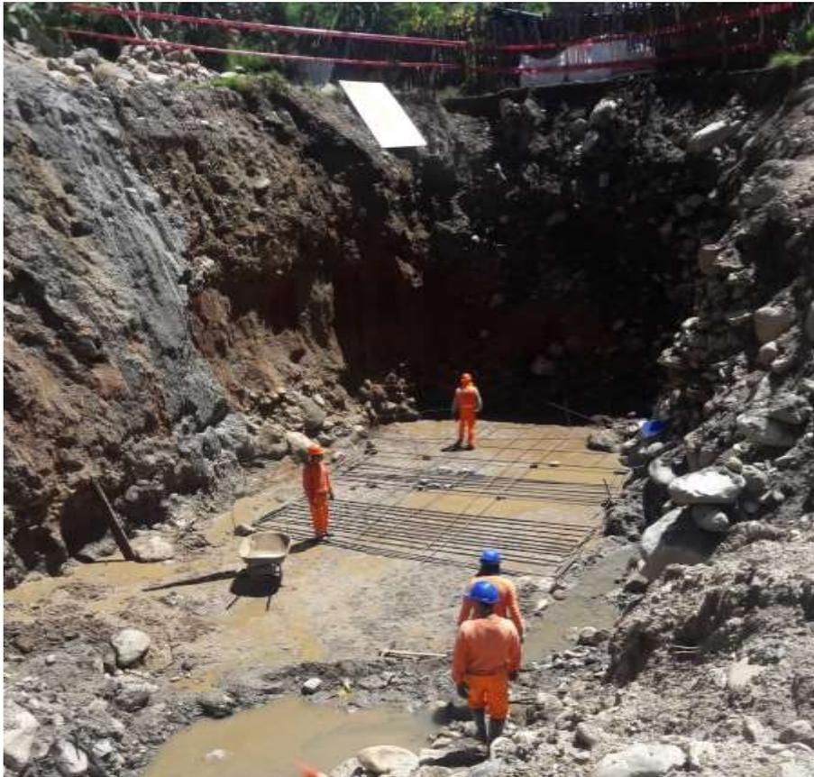
Imagen 08. Armado de la zapata del estribo- Peligro de terreno, talud
