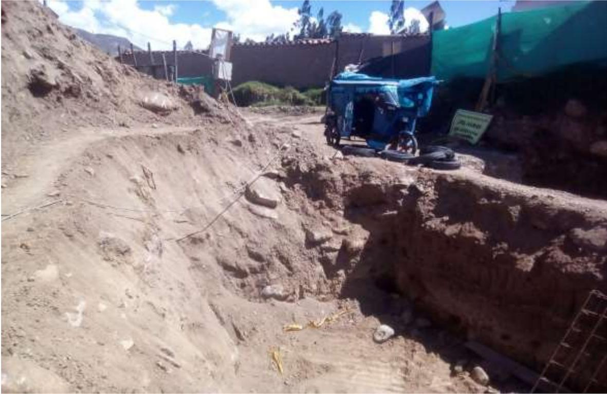
Imagen 61. Falta de señalizaciones, por excavación.
