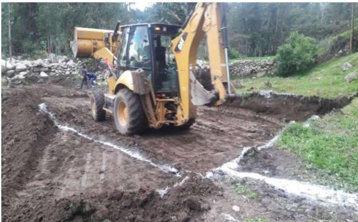
Imagen 03. Corte del terreno para el mejoramiento del puente Obraje localizado en la Provincia de Carhuaz, Distrito de Carhuaz, Ancash-2017
