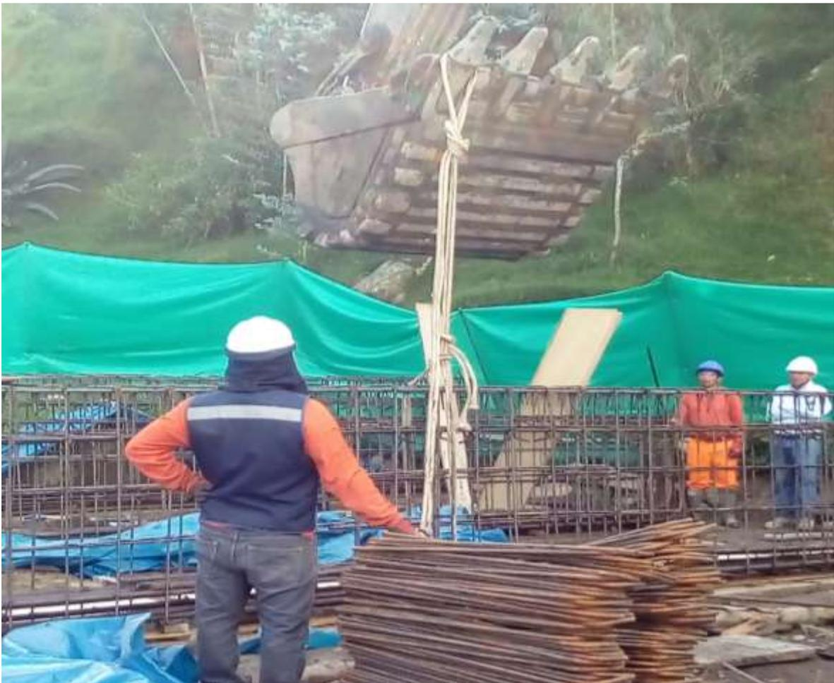
Imagen 36.Izaje de viga con excavadora. Peligro de la misma maquina.
