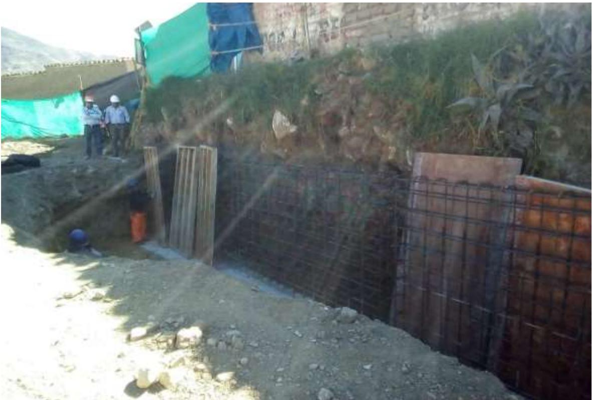
Imagen 66.Encofrado de muro de contención.
