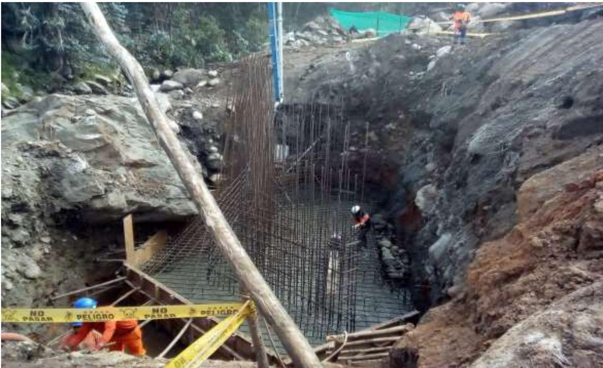
Imagen 10. Armado de estribo en un espacio confinado con difícil acceso
