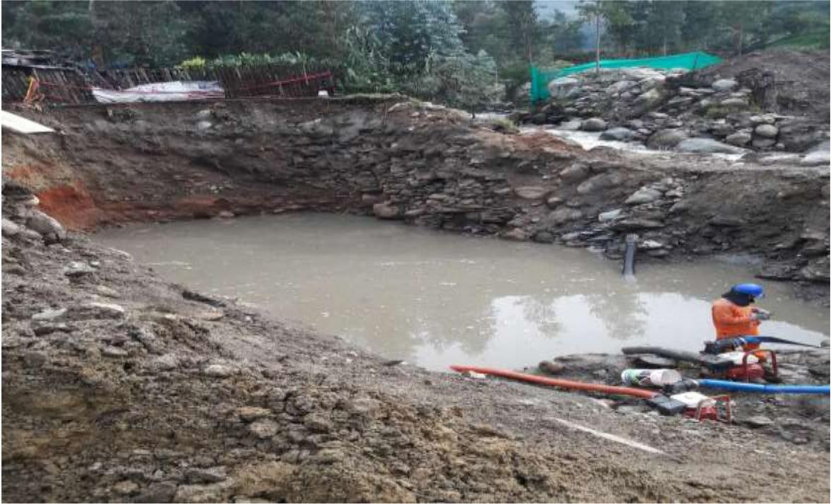
Imagen 07. Estracción del agua con bomba-Riesgo de caídas, ahogamiento.
