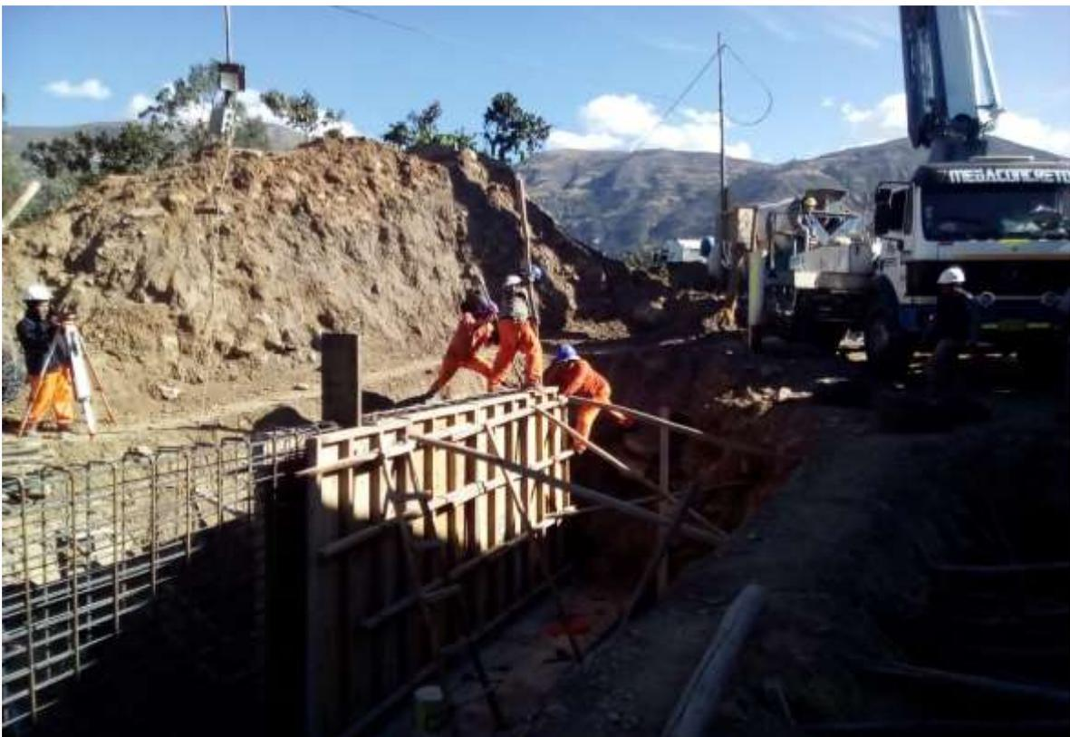
Imagen 68. Vaciado de muro de contención, peligro de altura, falta de arnés.
