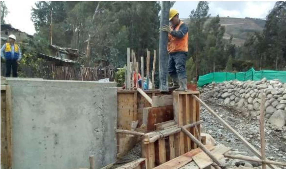
Imagen 22. Vaciado de aletas con mixer, Riesgo de golpes y caídas
