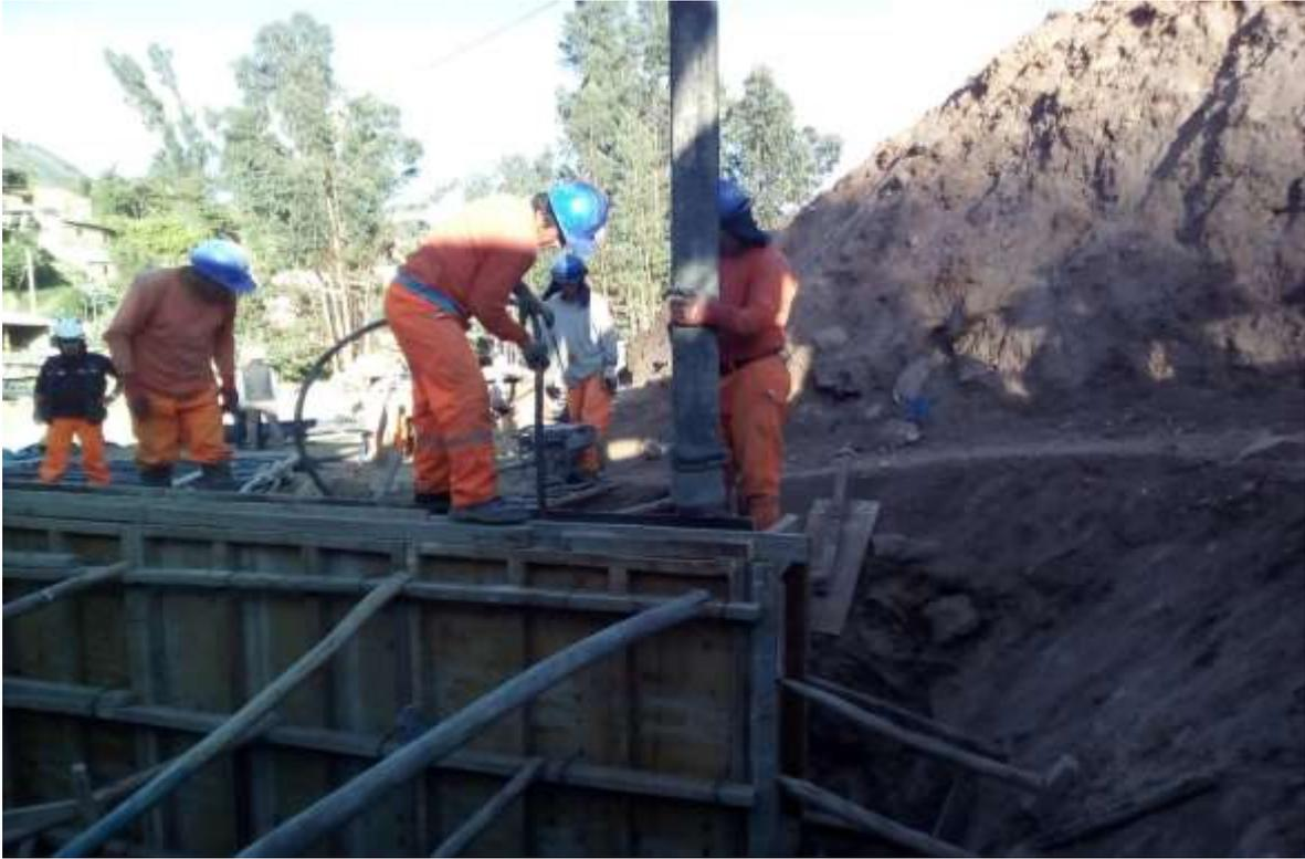
Imagen 71. Vaciado y vibrado de concreto.
