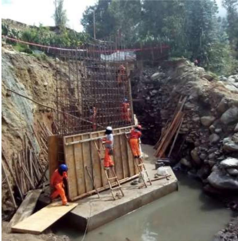
Imagen 11. Encofrado del estribo-Peligro, herramientas manuales, altura, acceso.
