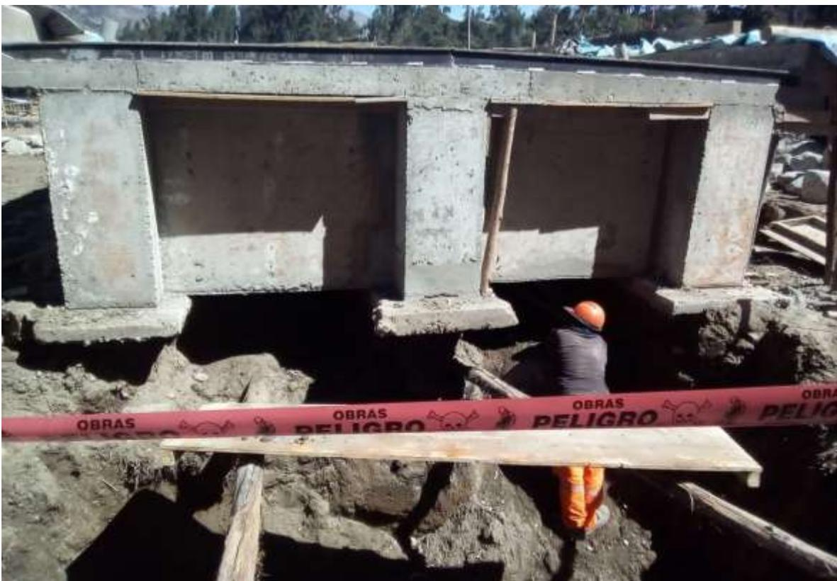
Imagen 82. Excavaciones manuales.
