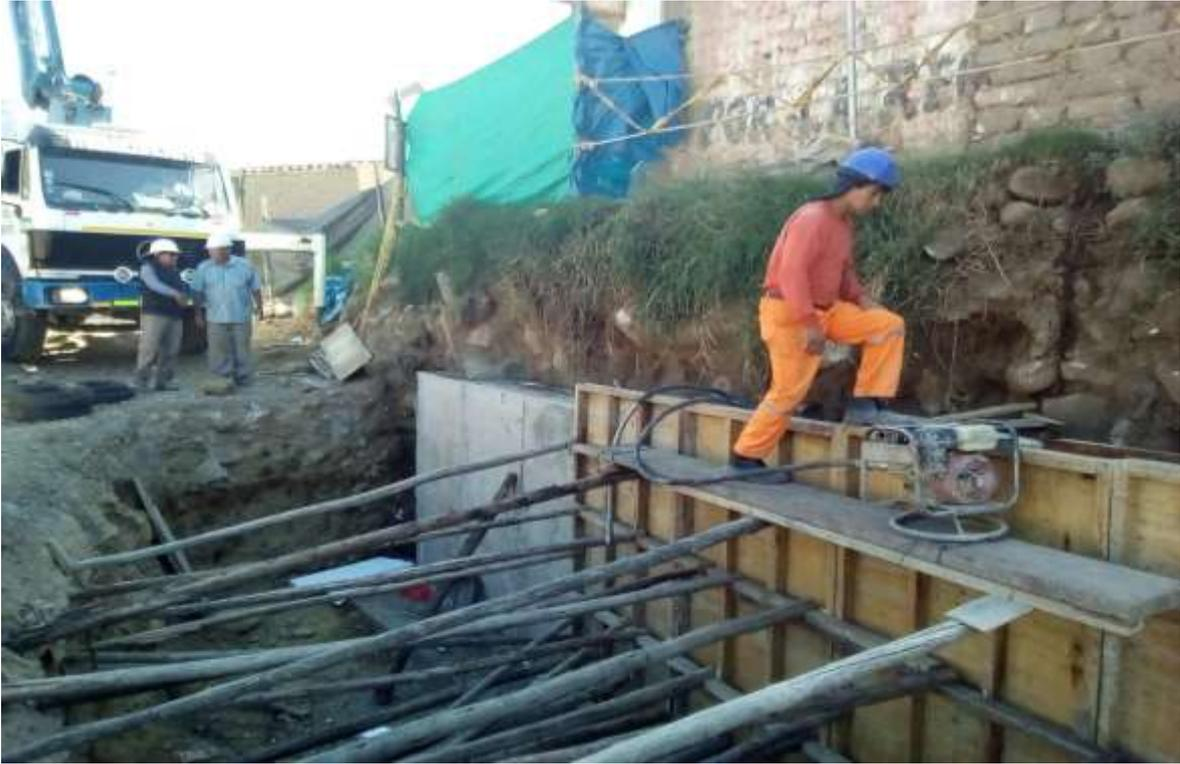
Imagen 73. Falta de señalización y EPP
