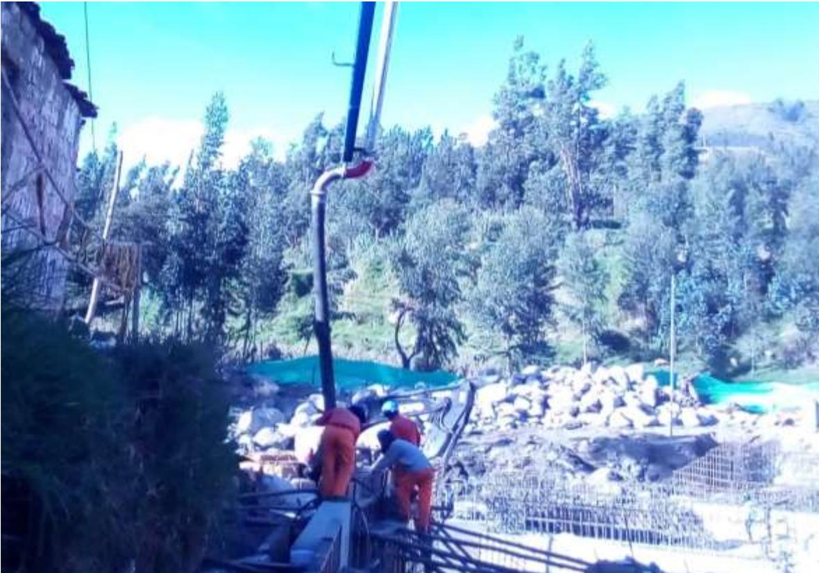
Imagen 74, Malas posturas al vibrar y vaciado el concreto.
