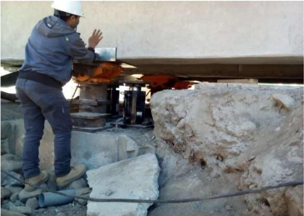
Imagen 90. Lanzamiento del puente, uso de gatas hidráulicas.
