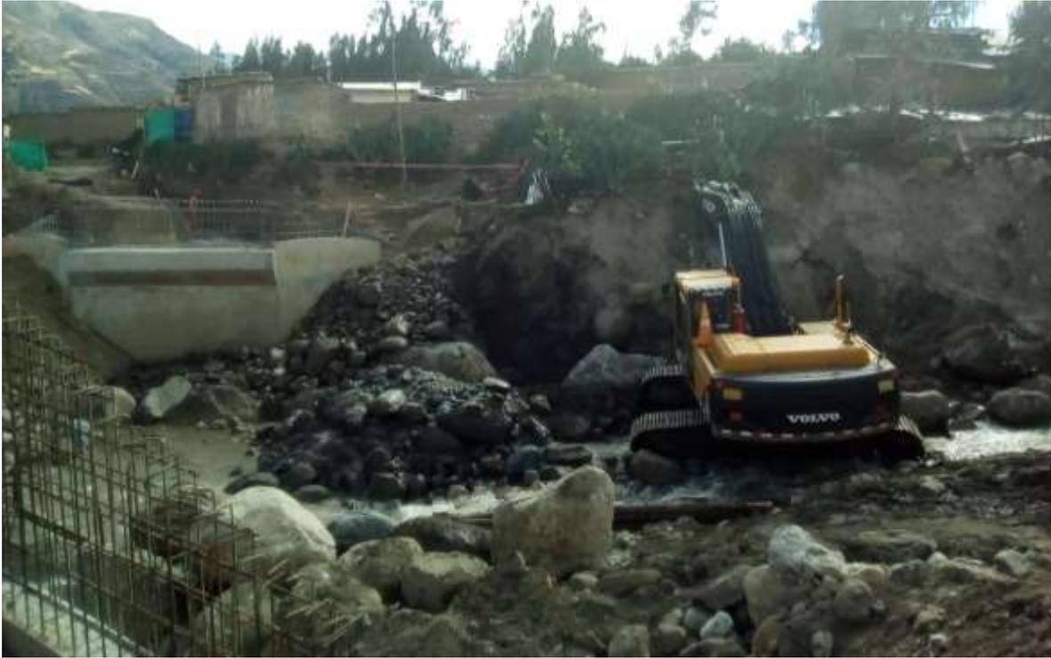
Imagen 31 Trabajos de encausamiento, Riesgo de derrumbe
