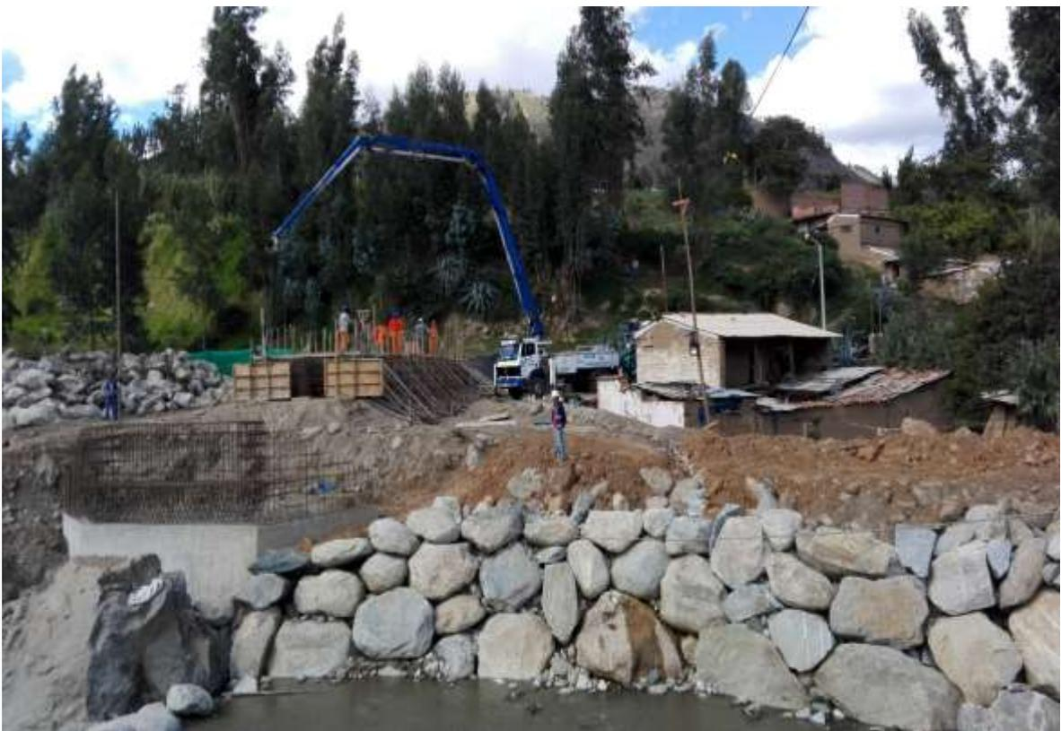
Imagen 52.Vaciado de losa de puente con mixer.
