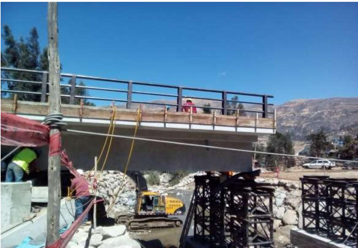
Imagen 94. Lanzamiento del puente.
