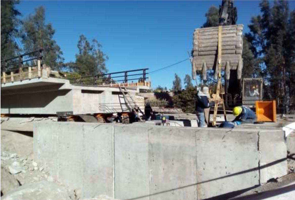
Imagen 87. Lanzamiento del puente, transporte de los gatos hidráulicos.
