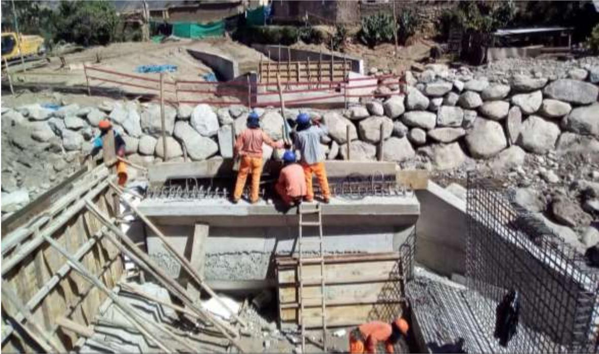
Imagen 23. Trabajos de encofrado.
