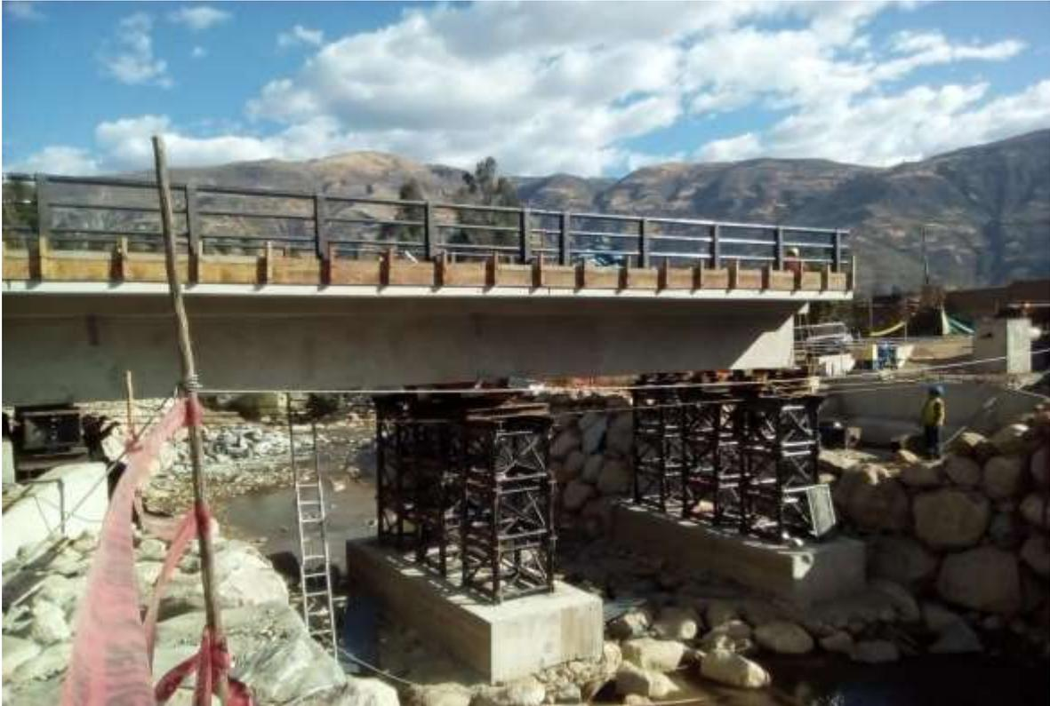
Imagen 95.Lanzamiento del puente con gatas higraulicas.
