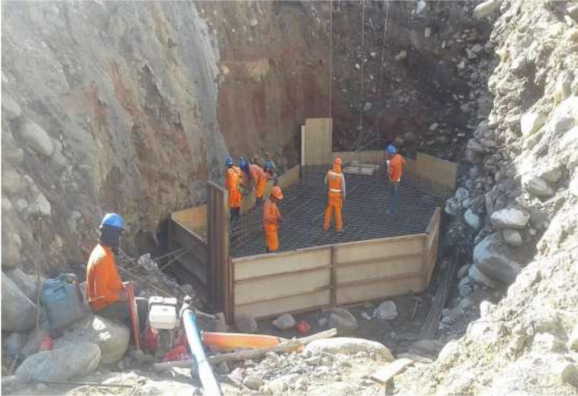
Imagen 09. Encofrado de la zapata del estribo-Riesgo de cortes
