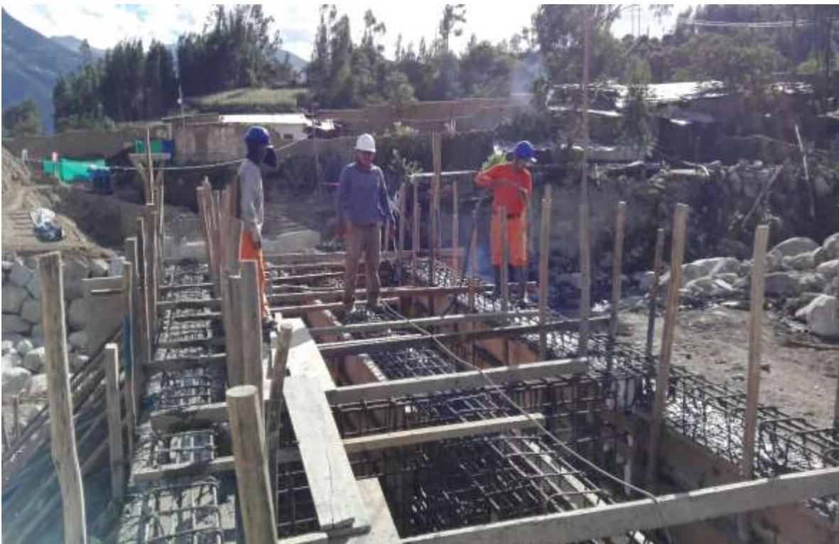
Imagen 42. Vaciado de vigas principales con mixer, peligro de altura.
