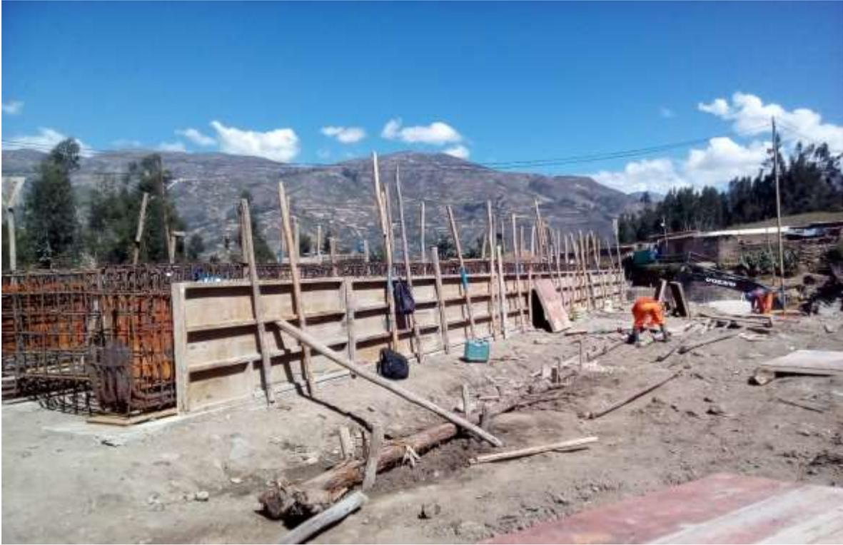
Imagen 39. Encofrado de vigas.
