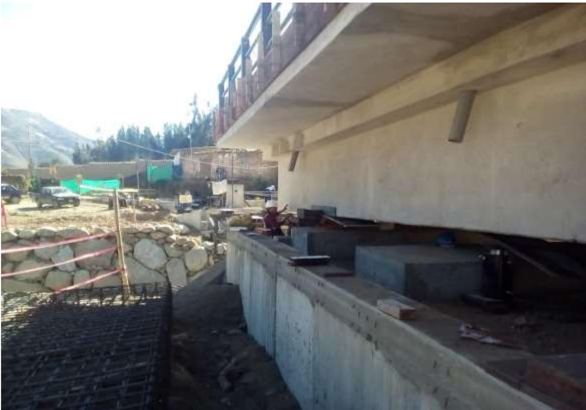
Imagen 92. Lanzamiento del puente, riesgo de corte con las planchas de aluminio
