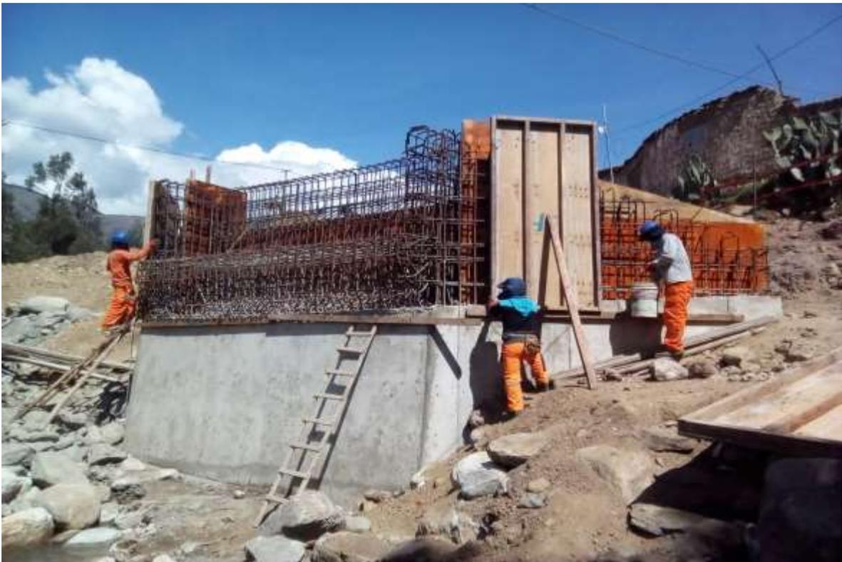
Imagen 20. Encofrado de las aletas del estribo
