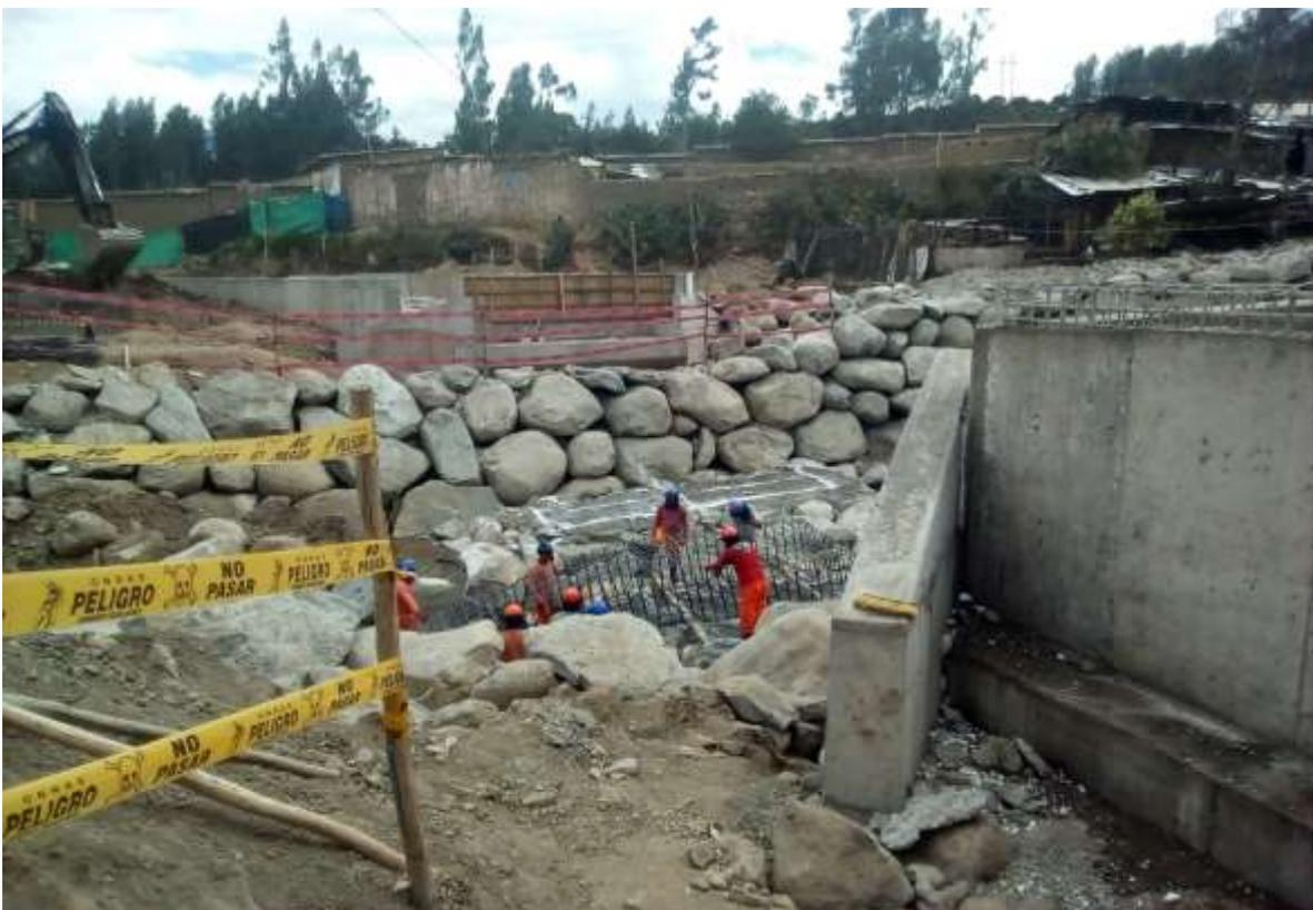
Imagen 80. Traslado de malla de zapata, excesivo peso.
