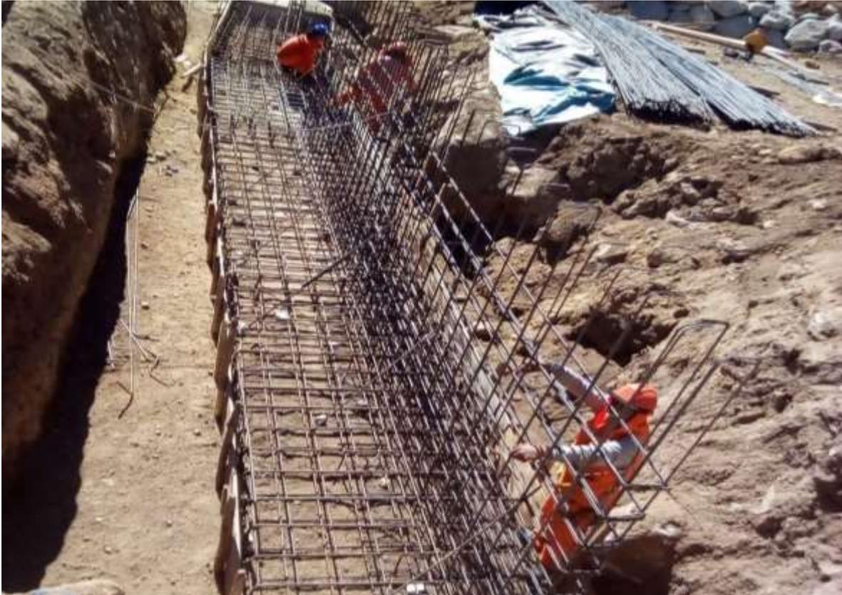
Imagen 63. Armado de zapatas y muro de contención.
