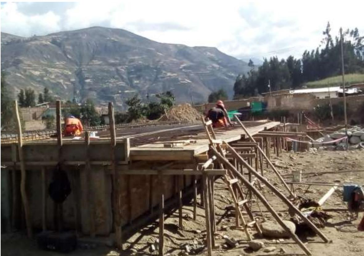
Imagen 48 Armado de losa de puente
