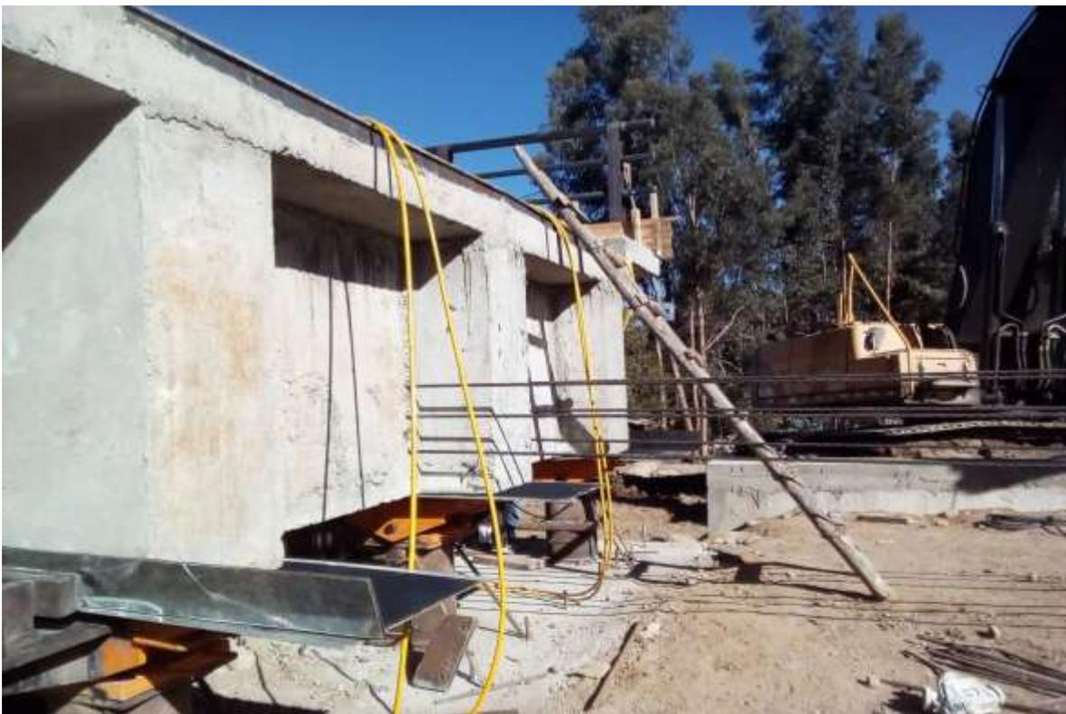
Imagen 88. Lanzamiento del puente, primeros movimientos del puente.
