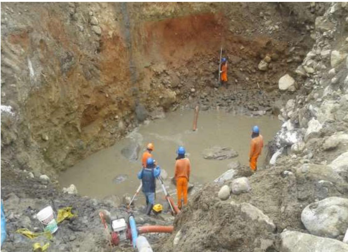
Imagen 06. Levantamiento topográfico para estribo- Riesgo de derrumbe, golpes
