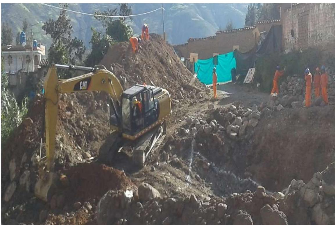
Imagen 04. Movimiento de tierra del mejoramiento del puente Obraje localizado en la Provincia de Carhuaz, Distrito de Carhuaz, Ancash-2017 – Peligro de altura.
