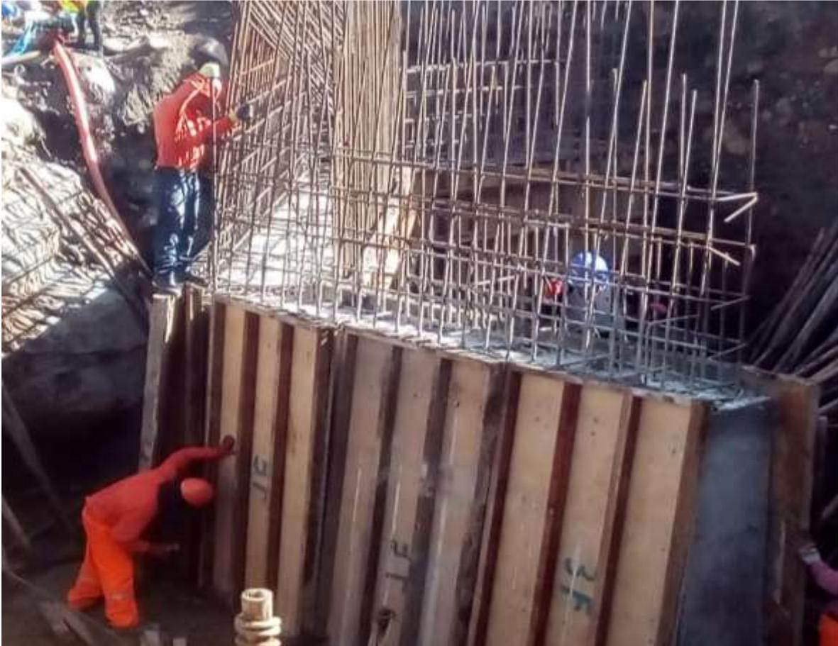
Imagen 13.Desencofrado del estribo con escaso uso de EPP (arnés), Peligro, altura
