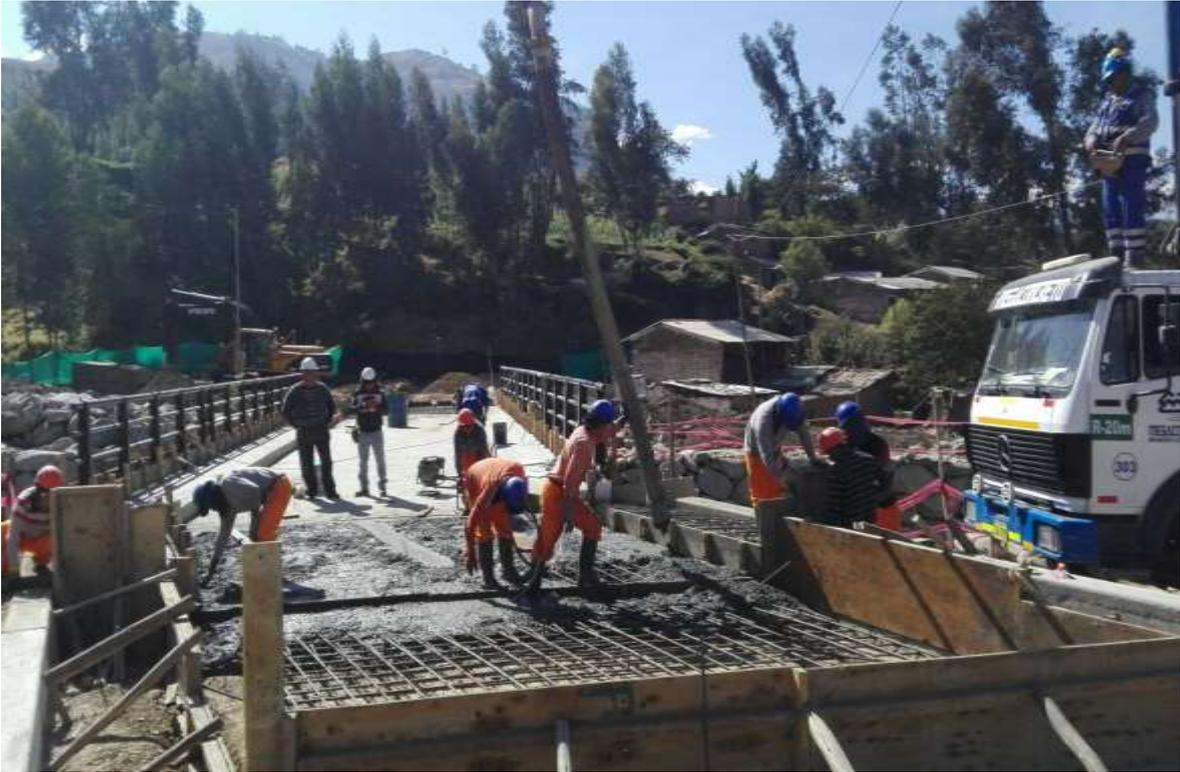
Imagen 99. Vaciado y vibrado de losa de aproximación.
