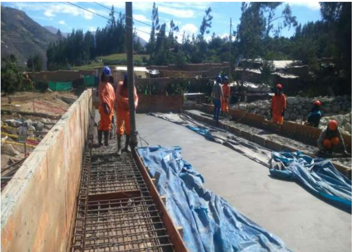
Imagen 54.Vaciado de la vereda.
