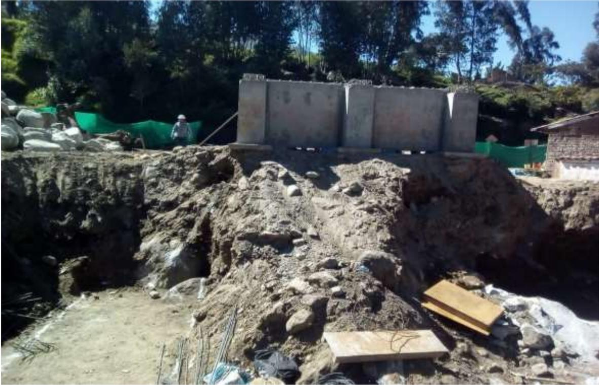
Imagen 45. Falta de señalización para las actividades de excavación.
