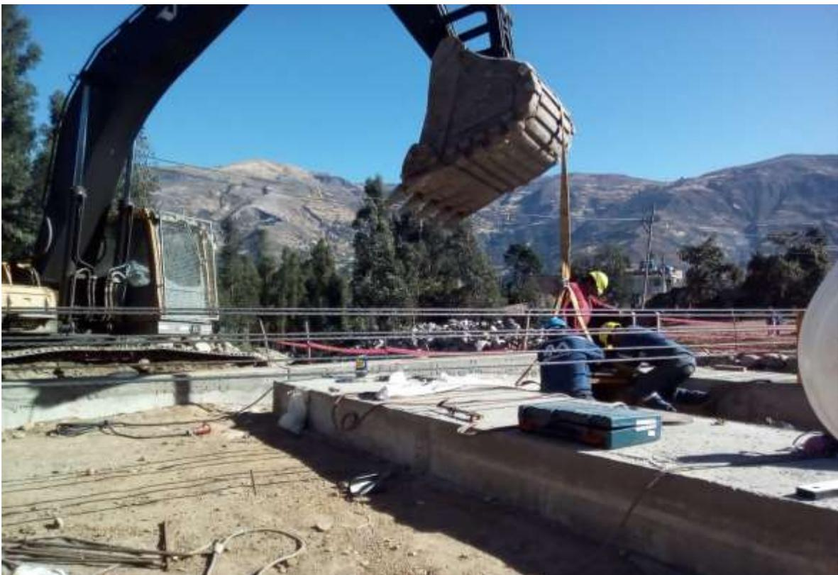
Imagen 86. transporte de los gatos hidráulicos, riesgo de golpe, aplastamiento
