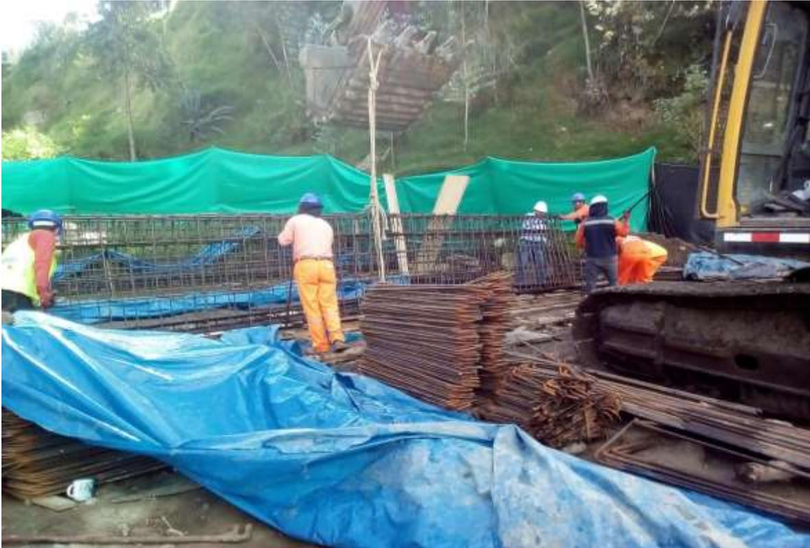
Imagen 37. Herramientas inadecuadas para mover viga.
