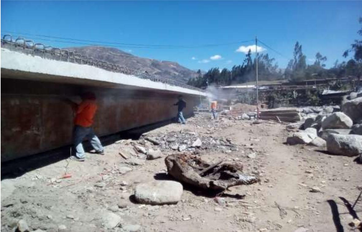
Imagen 57. Pulido del puente, falta de uso de mascarilla
