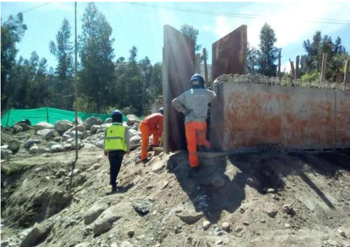
Imagen 44.encofrado de vigas diafragma, Riesgo de golpes, caídas a otro nivel
