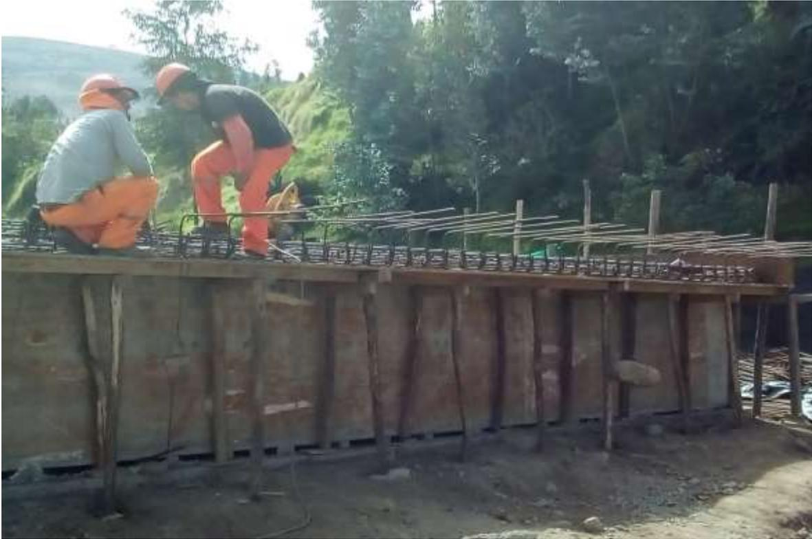
Imagen 47. Armado de vereda de puente.
