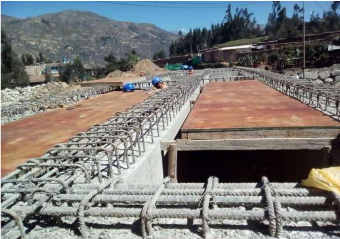
Imagen 46. Encofrado de losa de puente,
