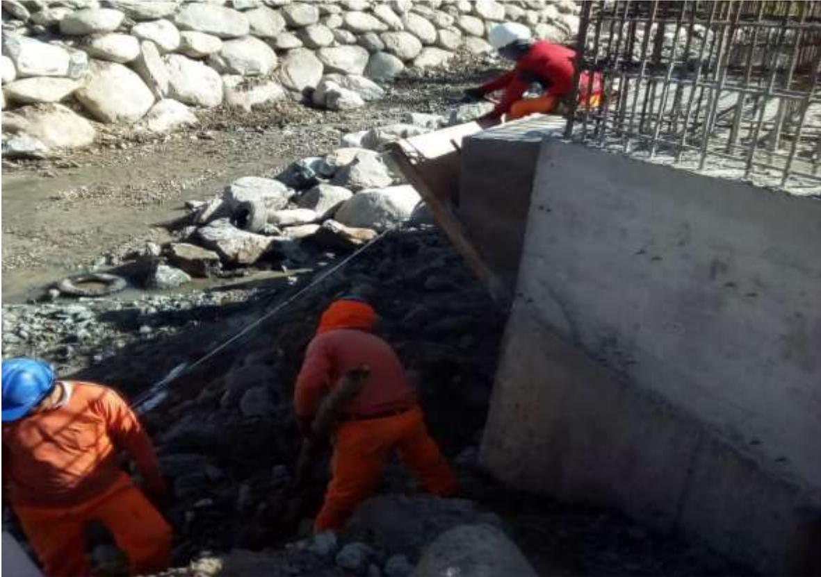
Imagen 21.Desencofrado de la meseta. Riesgo de aplastamiento por panel.
