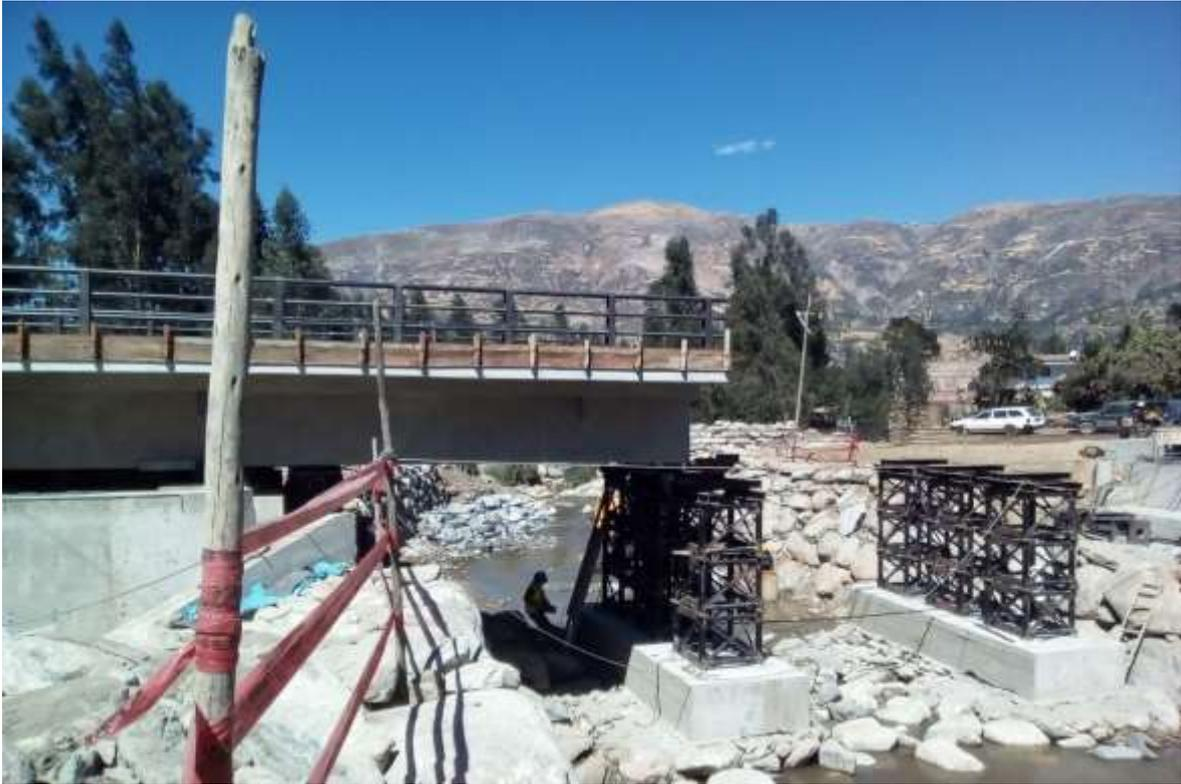
Imagen 93. Lanzamiento del puente.
