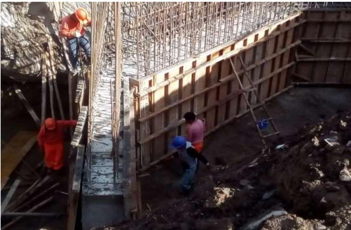
Imagen 12. Desencofrado de estribo, falta de uso de EPP.
