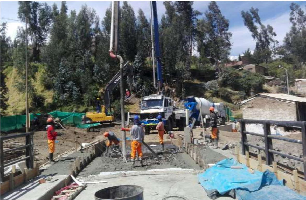
Image100. Vaciado de losa de aproximación.
