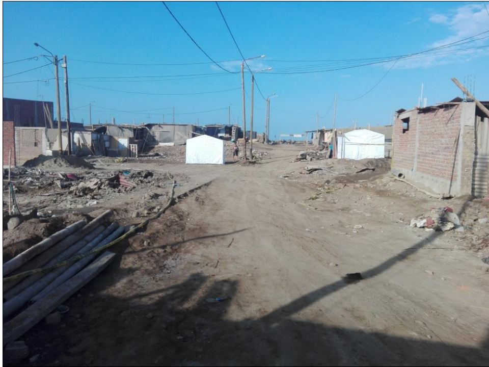
Figura 65: Viviendas Colapsadas del AA.HH. El Progreso.
