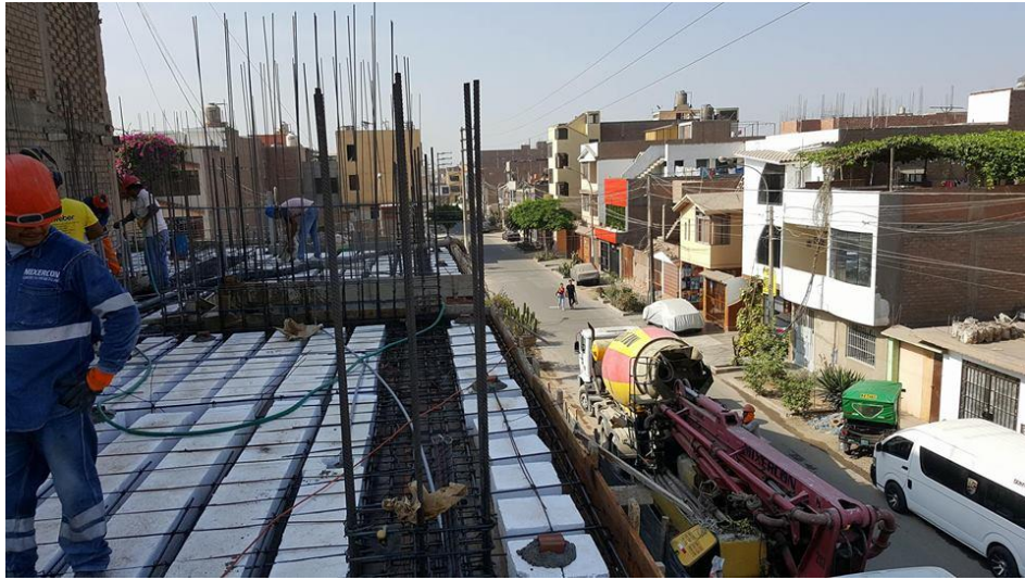
Figura 3.4 Preparación de área para vaciado de losa con concreto premezclado
