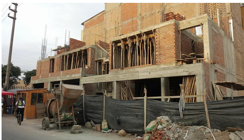
Figura 3.3 Vista panorámica del edificio Zaragoza en fase de ejecución
