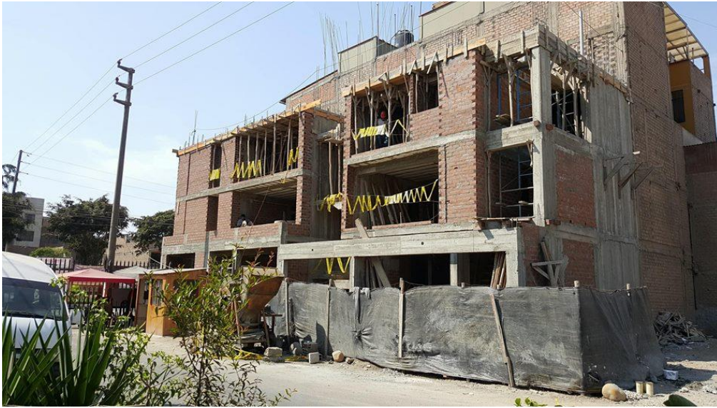
Figura 1.1 Vista panorámica de la construcción del edificio multifamiliar Zaragoza
