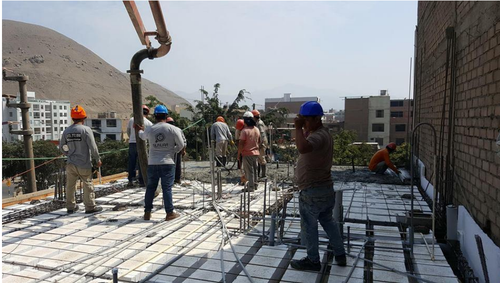
Figura 1.2 Vaceado de concreto en losa de segundo nivel en la construcción del edificio multifamiliar Zaragoza
