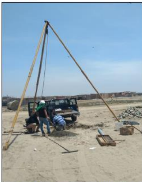
TRÍPODE INSTALADO E INICIO DE EXCAVACIÓN DE CALICATA
