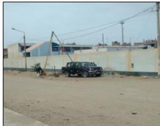
INSTALACIÓN DE TRÍPODE DE ACERO PARA EJECUCIÓN DEL SONDEO SPT N° 01
