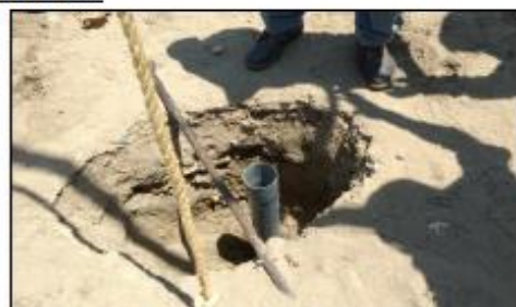
COLOCACIÓN DE TUBERÍA PARA EVITAR DESMORONAMIENTO DE PAREDES DE ARENA SATURADA
