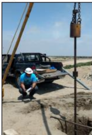
CONTABILIZACIÓN DE GOLPES EN HINCADO
