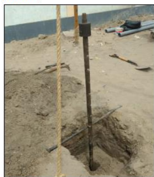
INSTALACIÓN DE CAÑAS MÁS MUESTREADOR PARA PRIMER HINCADO EN PUNTO SPT N° 01
