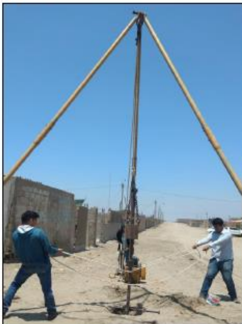
EJECUCIÓN DEL SONDEO SPT N° 03
