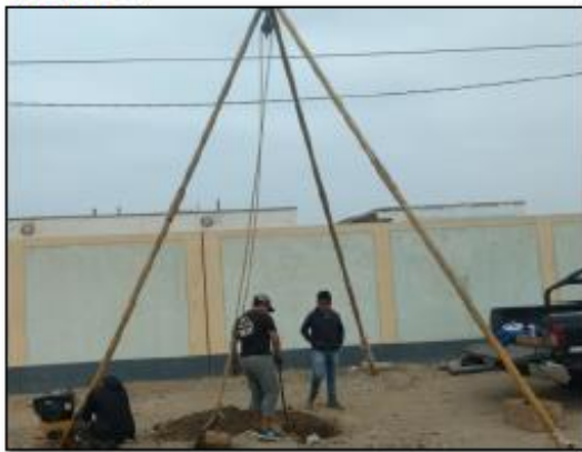
EXCAVACIÓN DE CALICATA DE 1.00 m PARA DAR INICIO A SONDEO SPT N° 01
