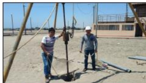
INSTALACIÓN DE CAÑAS CON MUESTREADOR PARA HINCAR UN ESTRATO NUEVO
