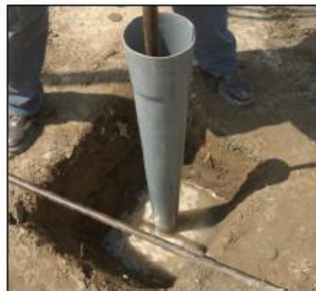
COLOCACIÓN DE TUBO PARA FACILITAR EN PRINCIPIO TRABAJOS DE POSTEO DEBIDO A NIVEL FREÁTICO ELEVADO
