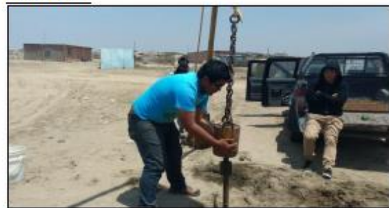
COLOCACIÓN DE YUNQUE PARA DAR INICIO AL SONDEO
