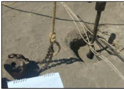
CALICATA CON POSTEO INCLUIDO PARA DAR INICIO AL SONDEO SPT N° 04
