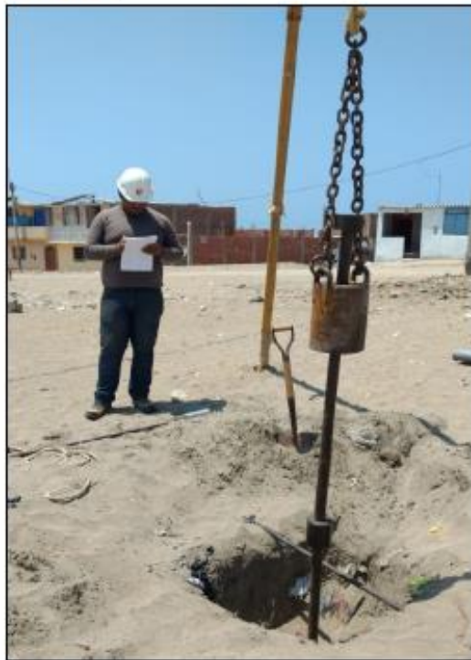
EJECUCIÓN DE SONDEO SPT N° 05
