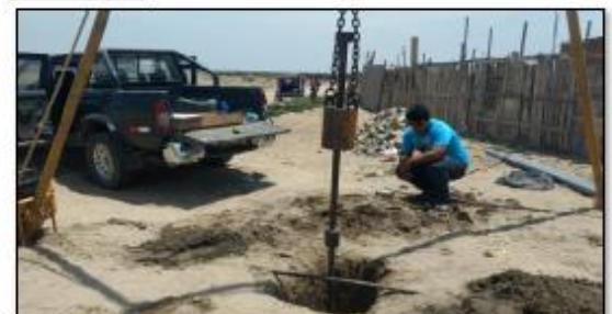
EJECUCIÓN DEL SONDEO SPT N° 02
