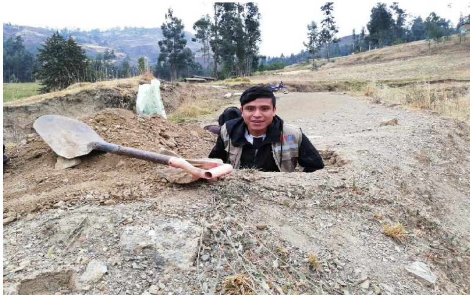
Calicatas en la vía
