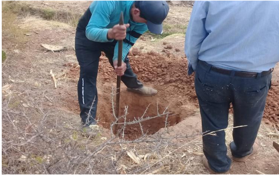
Excavación de la calicata para obtener las muestras
