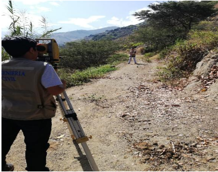
Realizando el levantamiento topográfico del tramo Chocón-Suro
