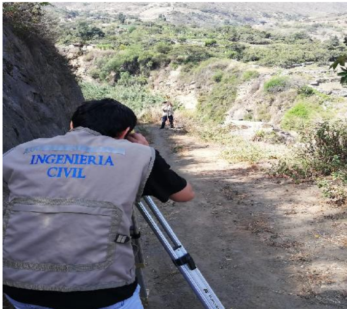
Realizando el levantamiento topográfico del tramo Chocón-Suro
