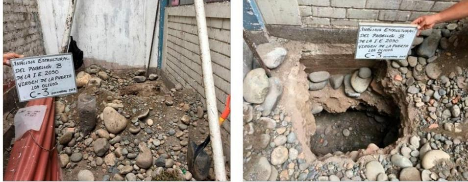
Foto N°05: Se observa la profundidad de la cimentación y el material granular existente en la zona..
