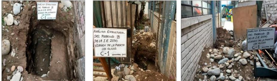
Foto N°04: Vista de la calicata N°1 donde se aprecia la profundidad de la cimentación y el material granular existente en la zona.
