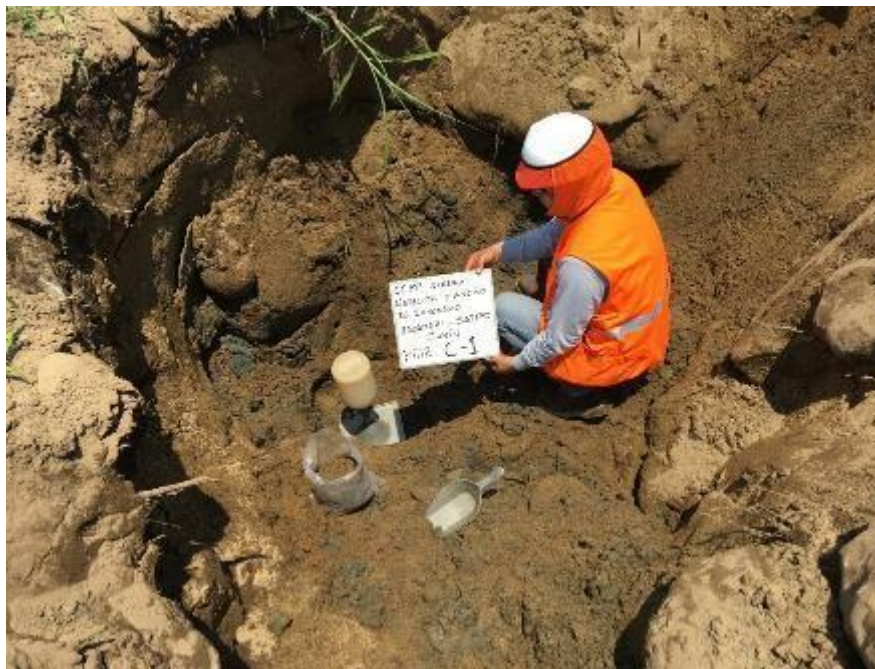
Foto 3. Determinación de la densidad In-Situ con el método del cono de arena.
