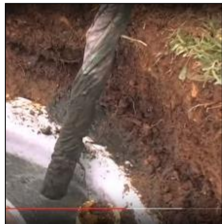
Figura 9: Palo con tela antes y después de introducirlo al tanque séptico
