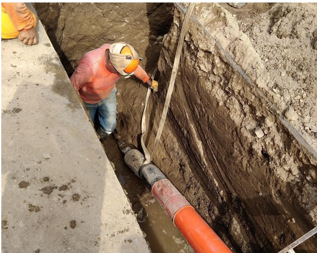
Figura 15: Colocación de tubería con cabezal en ventana de ingreso.
