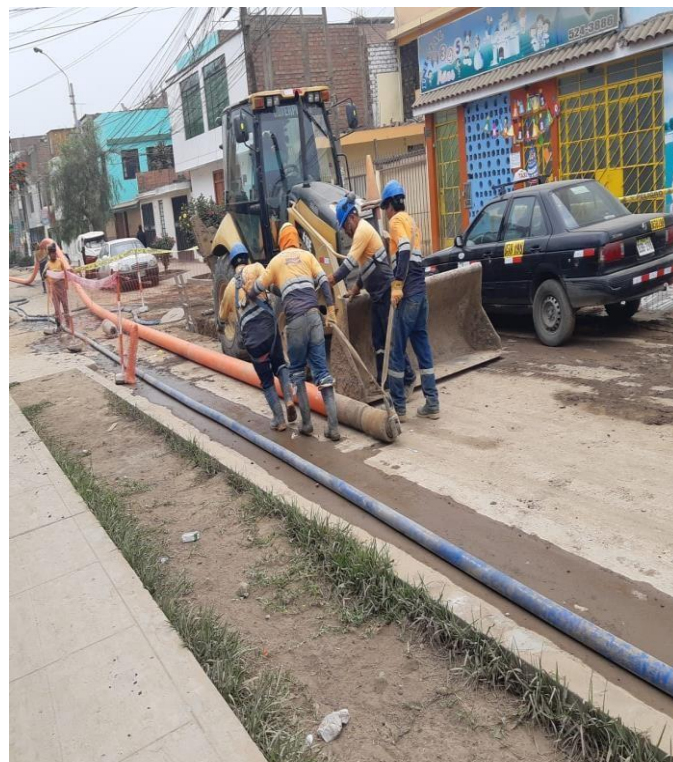
Figura 33: Colocación de tubería para la fragmentación
