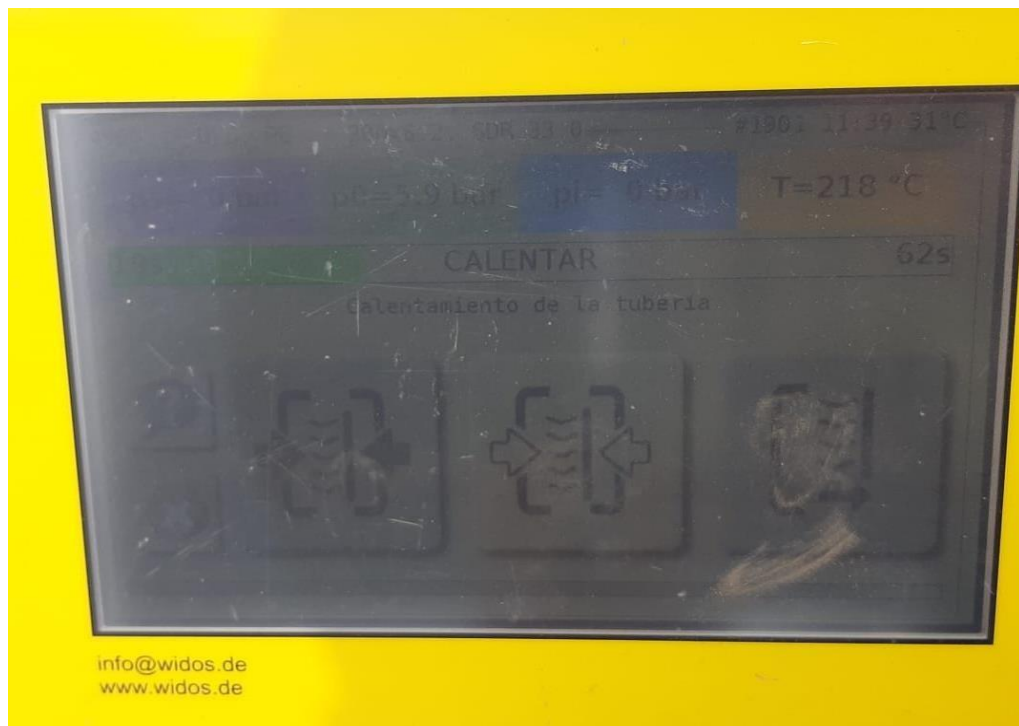
Figura 14. Fuente propia: Visor Digital de calentamiento y verificación de termofusión
