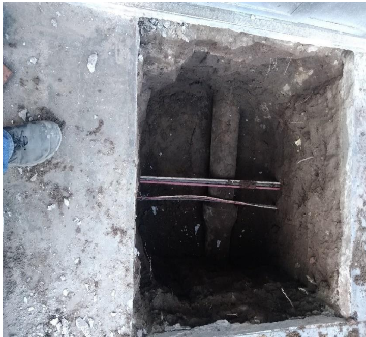
Figura 22 Cable eléctricos generando interferencias Fuente propia
