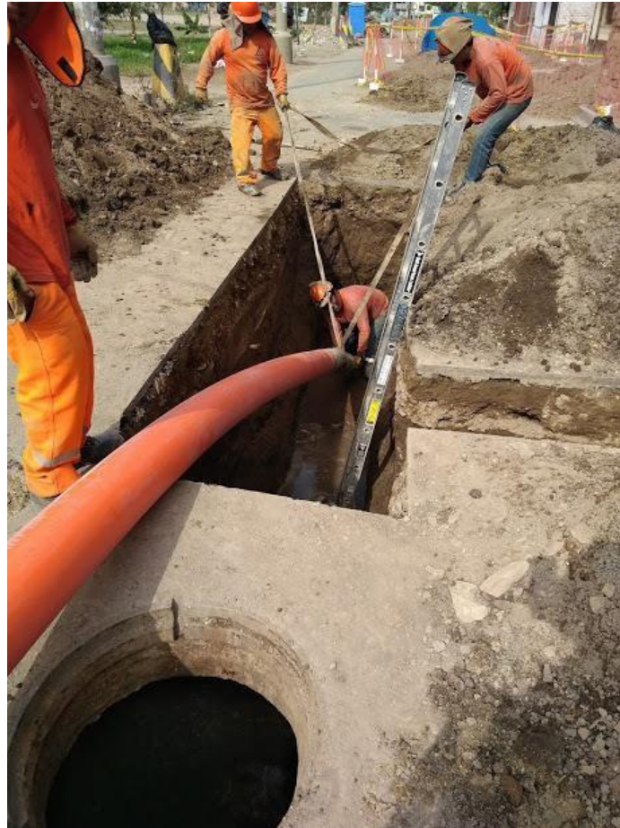
Figura 2 Fuente propia, instalación de nueva tubería de alcantarillado sin generar desperdicios
