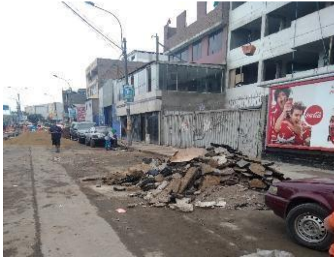
Figura 26 Falta de estacionamientos Fuente propia
