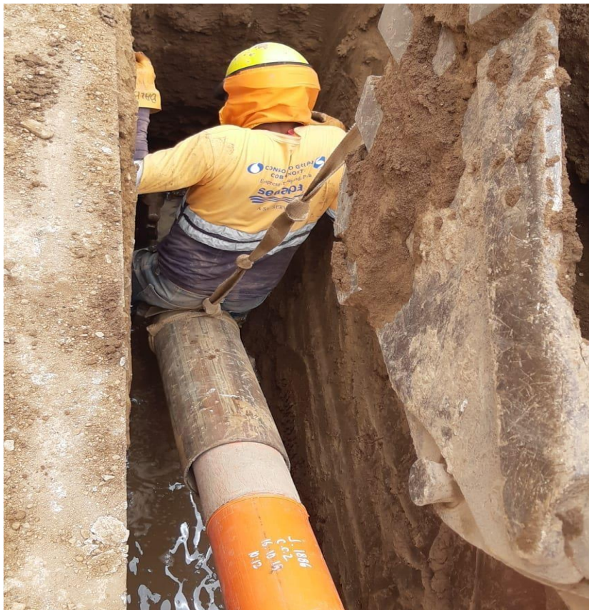
Figura 35: Ingreso de tuberías para realizar fragmentado
