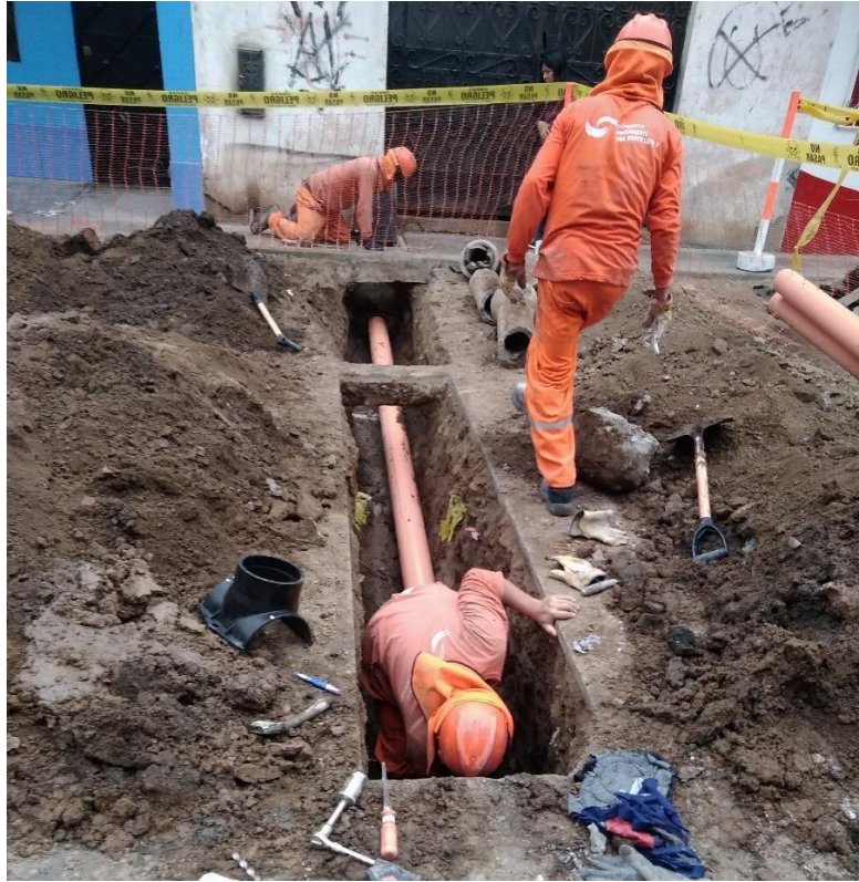
Figura 3 Fuente propia instalación de nueva tubería de alcantarillado.
