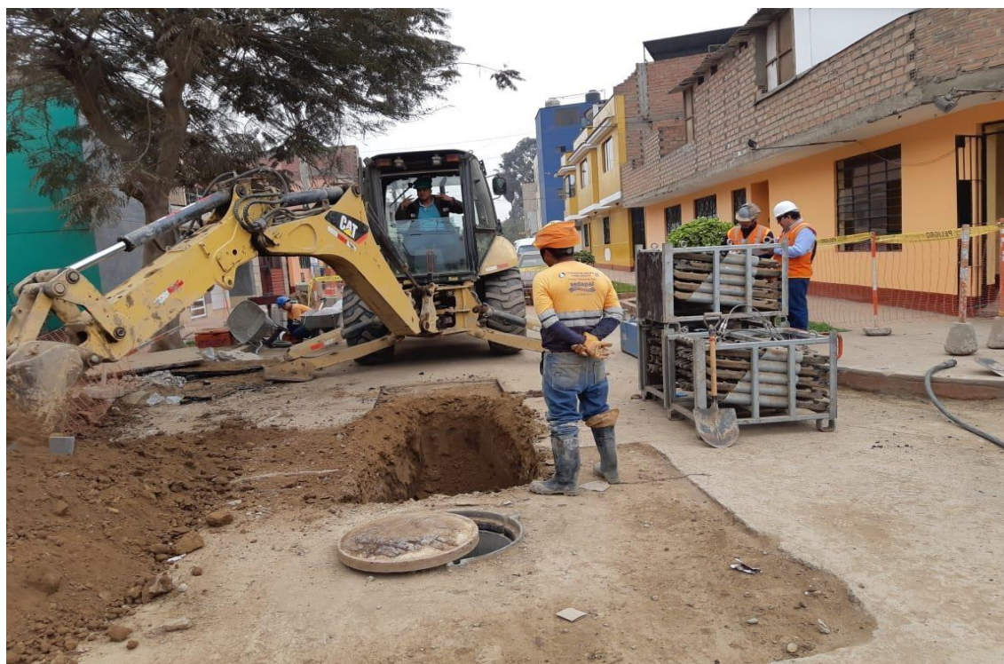
Figura 11. Fuente propia: Excavaciones para ventana de ingreso
