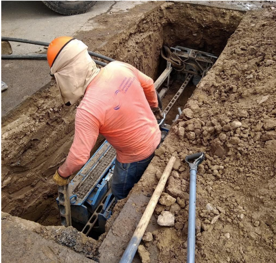
Figura 16. Instalación de la Unidad de Fuerza Hidráulica cen ventana de salida
