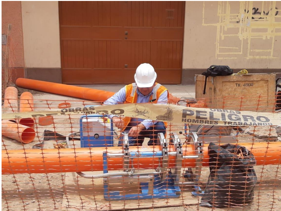
Figura 12. Montado de tubería en máquina de termofusión
