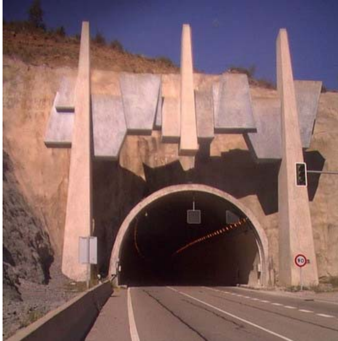
Figura 1: Túnel de Monrepós. Fuente: Manual de Túneles y Obras Subterráneas
