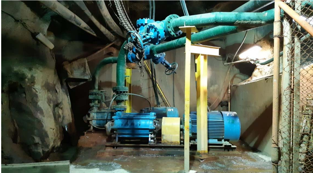
Figura 12: Ubicación de la estación de bombeo Nivel 820. Fuente: Mina San Cristóbal.
