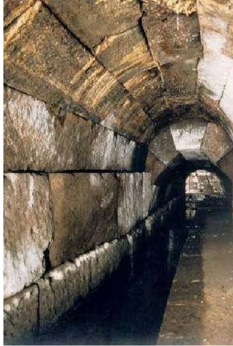
Figura 3: Cloaca máxima de Roma. Fuente: Manual de Túneles y Obras Subterráneas
