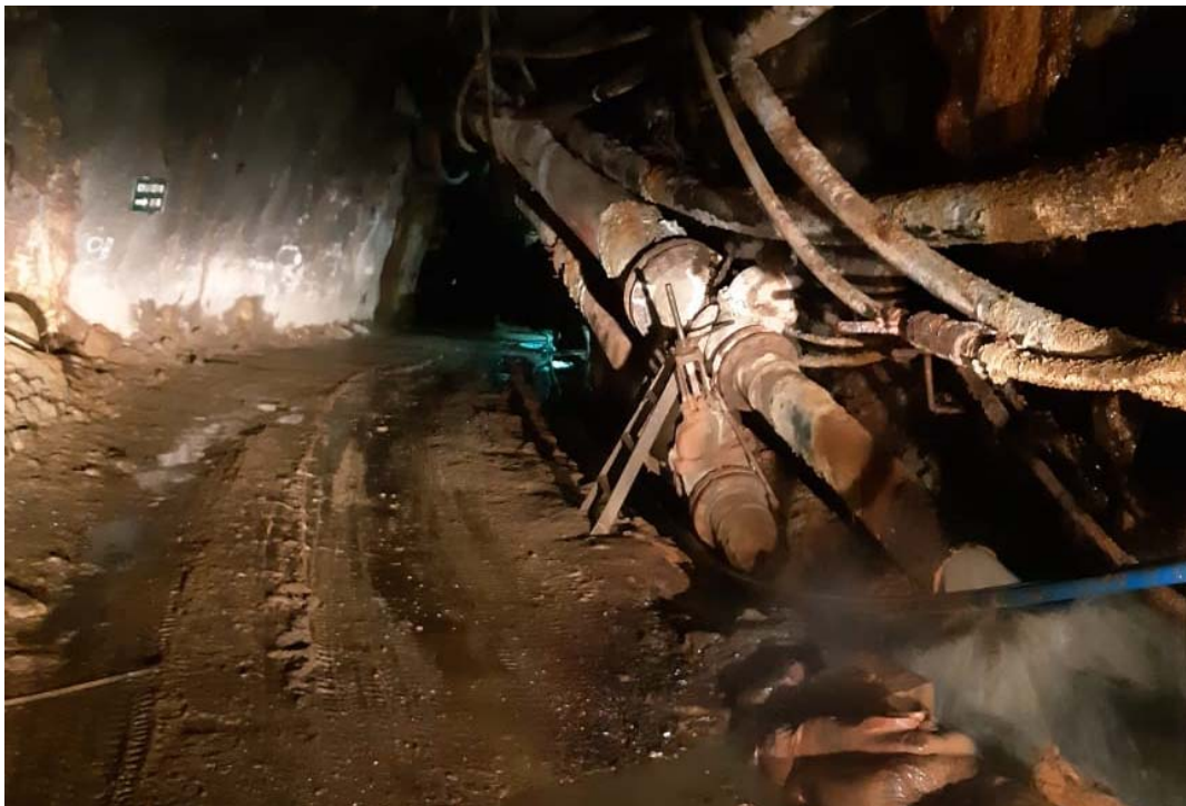
Figura 13: Ubicación de descarga hacia el Túnel Victoria Nivel 820. Fuente: Mina San Cristóbal.
