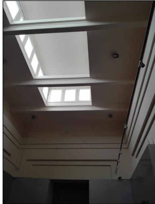
Figura 32: Vista del techo que ha sido pintado
