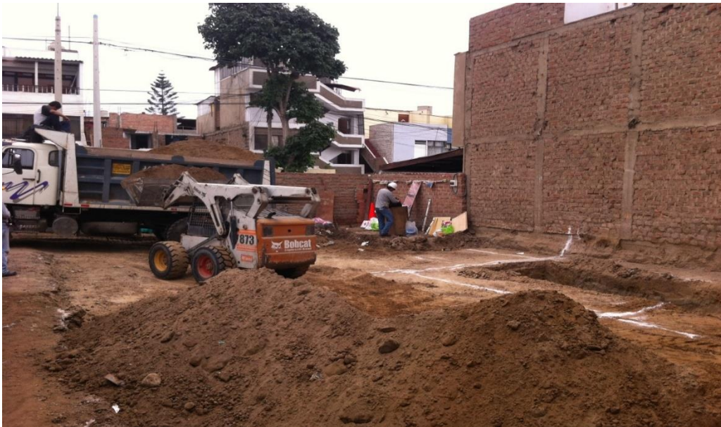
Figura n°4 Excavación del terreno de manera masiva.
