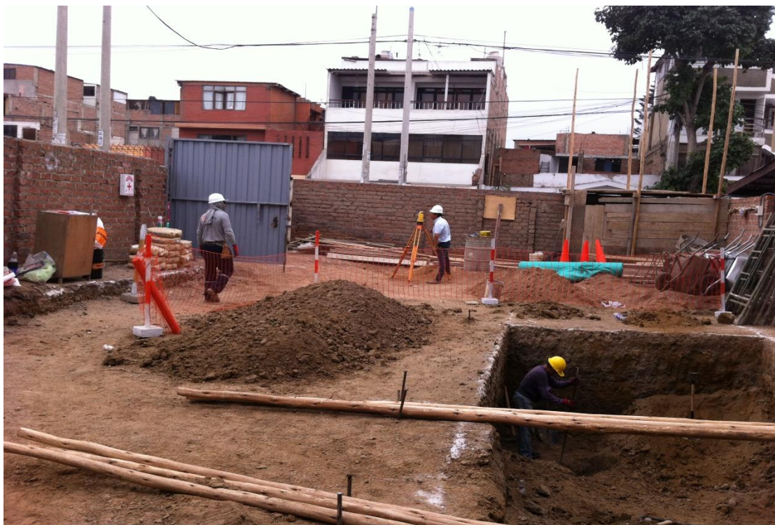
Figura n°3 Excavación del terreno de manera manual.
