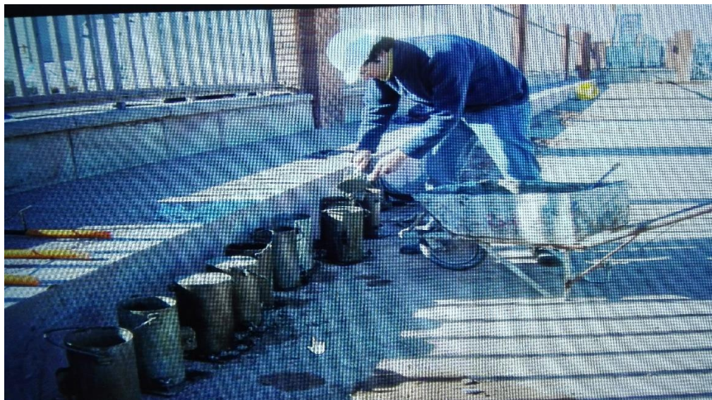
Figura 18. Llenado de los moldes. Fuente: Google
