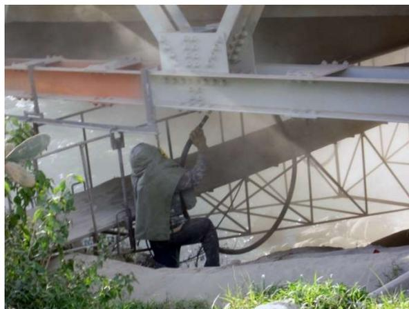
*Figura 2. Arenado en estructura metálica*
