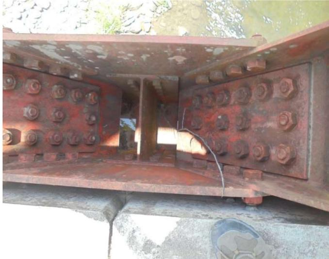
*Figura 11.* Pernos en regular estado de conservación en puente reticulado de 80.00m
