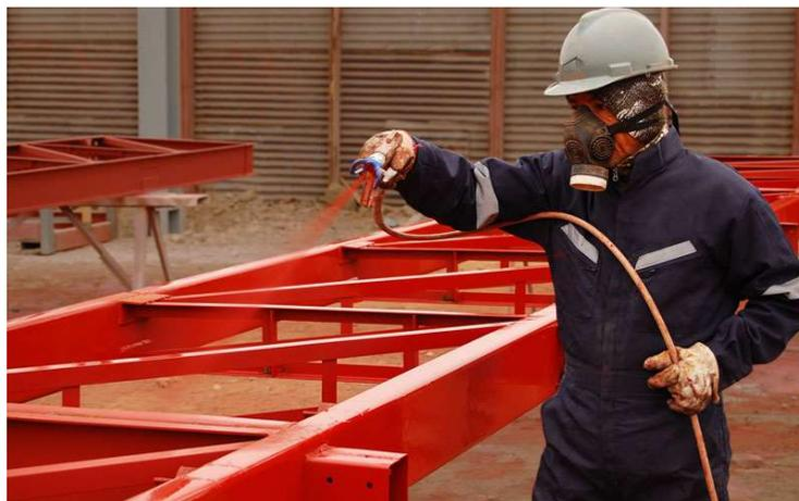
*Figura 7.* Pintado de estructura metálica con pistola
