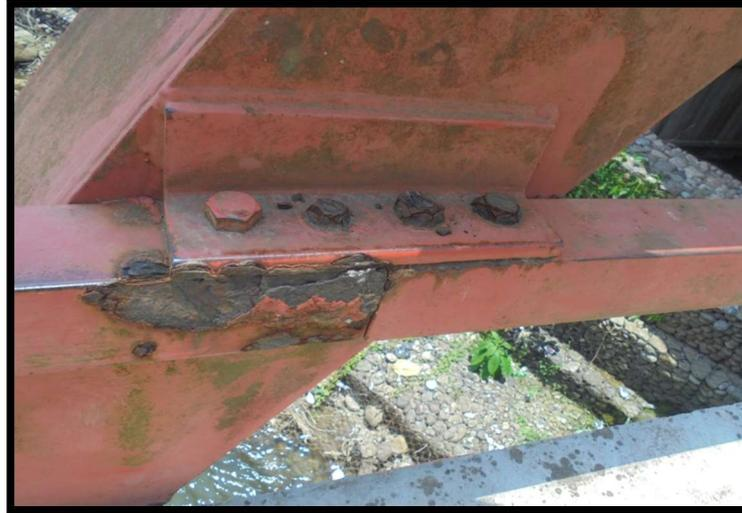
Figura 19. Pernos deteriorados en el Reticulado metálico de 50.00m
