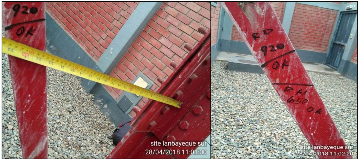
Vista área de reforzamiento.
