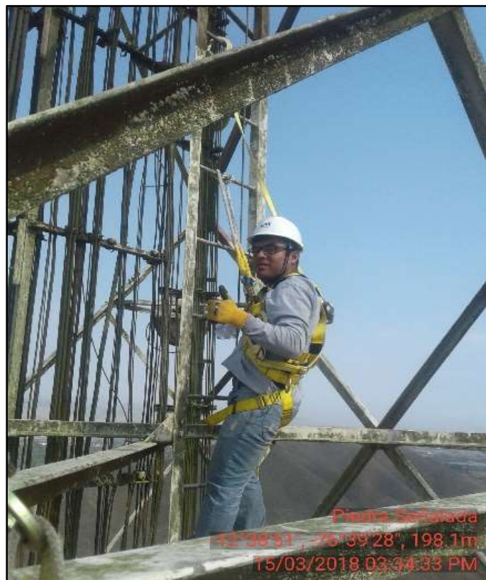
Figura 6: Vista operario subiendo por escalerilla rack peatonal (Piedra señalada)
