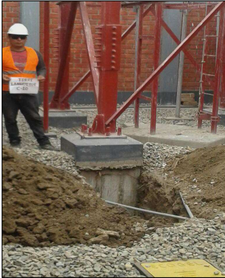
Figura 17: Vista de Calicata.
