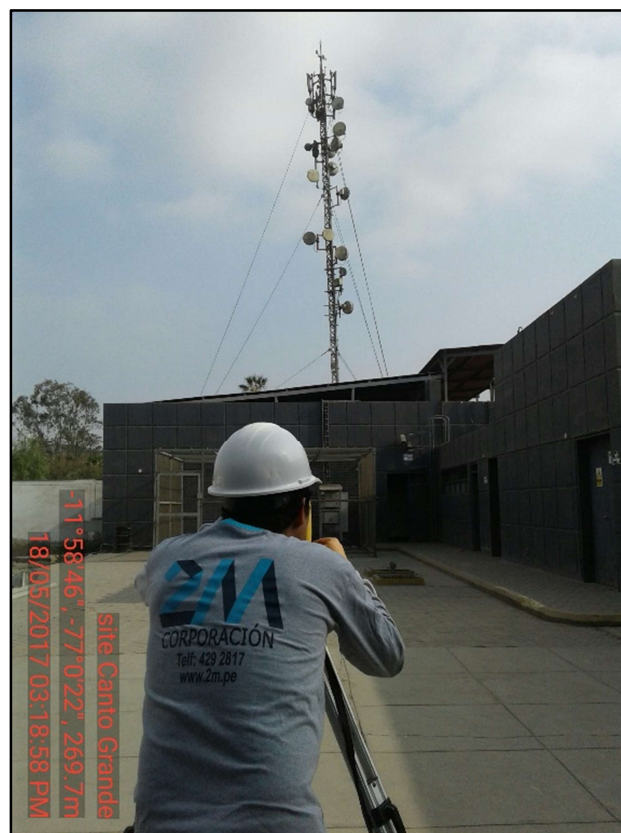
Figura 3: Vista Torre Arriostrada (Canto Grande)
