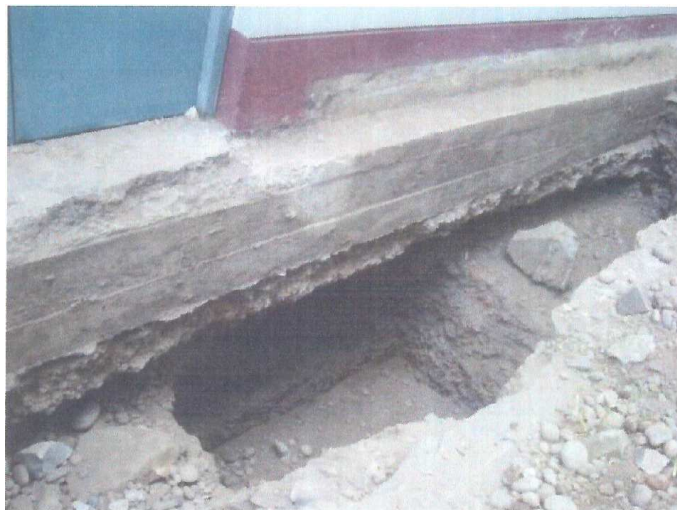
Figura 11. Cimentación MR-1 de poca anchura y poca profundidad en el eje 10 entre eje K-L.
