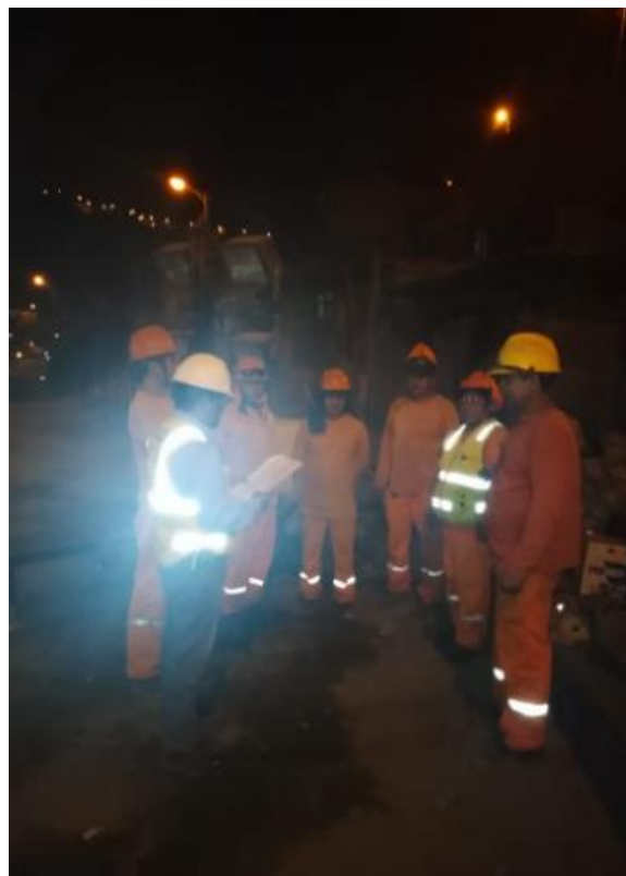
Registro Fotografico para los trabajos nocturnos en el sector
