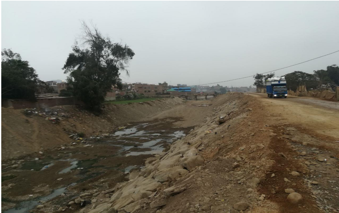
Registro 9: Observando que la zona de proyecto del río Huaycoloro tiene zonas de protección de enrocado.
