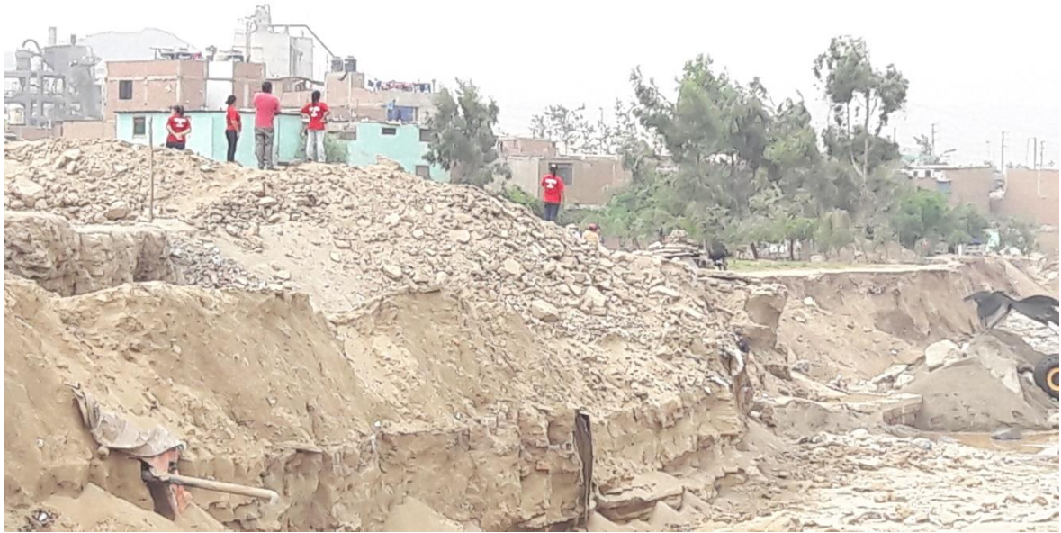
Registro 3: Talud del margen del río después del desbordamiento del río Huaycoloro.
