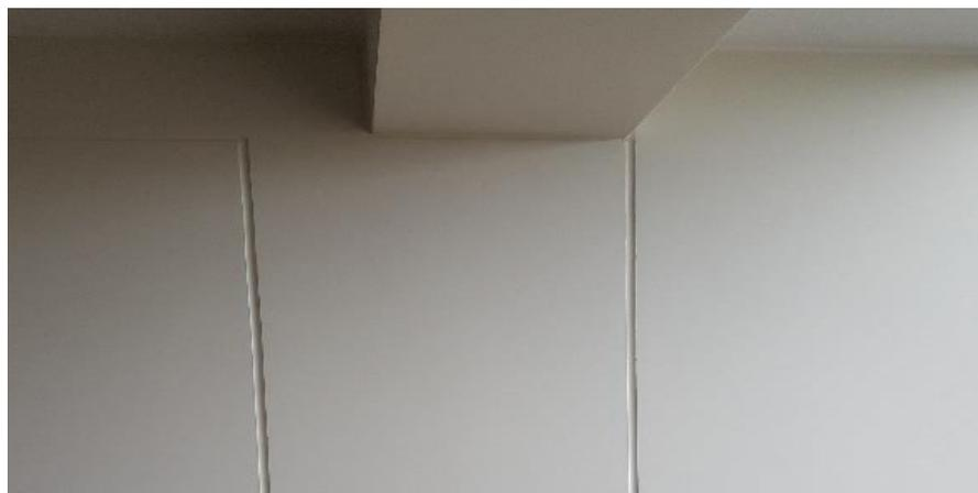
*Figura 96.* Juntas de dilatación en edificación aporticada
