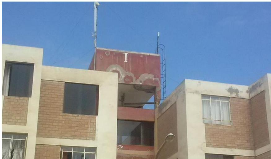
*Figura 2.* Fallas en la base del fuste del tanque, Edificio del departamento de Enace.
