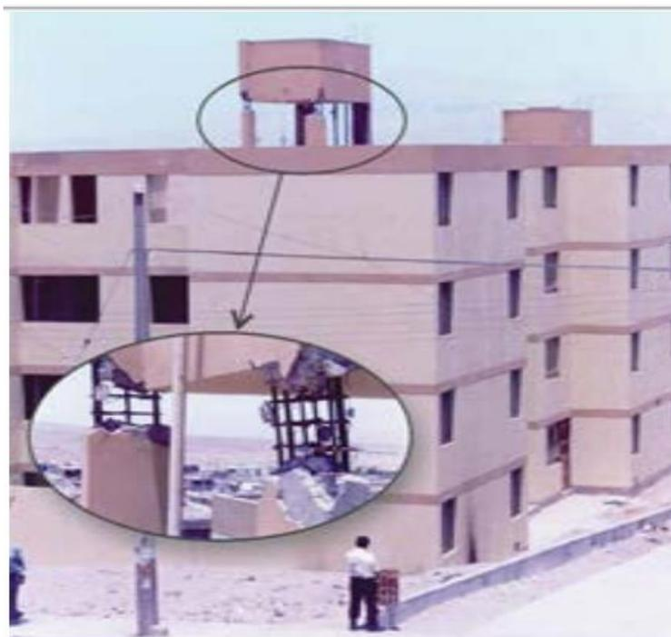
*Figura 1.* Daño en tanque elevado de agua en la parte de Azotea
