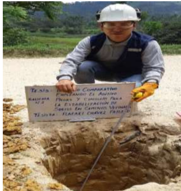
Foto N°6 Excavación de la calicata N°2.
