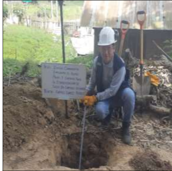
Foto N°2 Excavación de la calicata N°1. Fuente: Elaboración Propia
