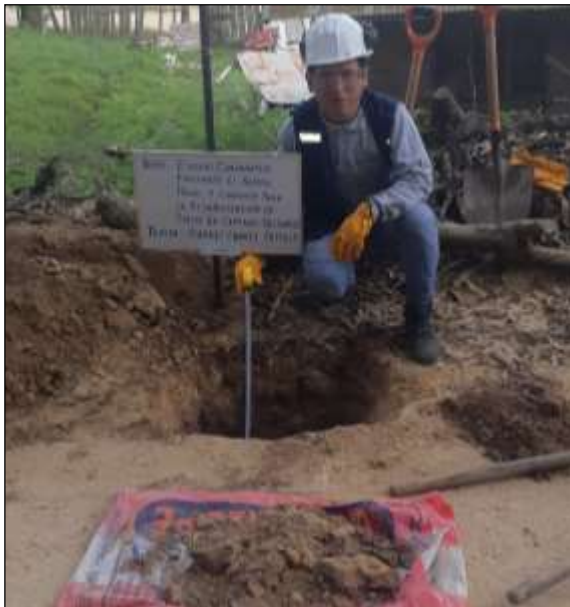
Foto N°3 Excavación de la calicata N°1. Fuente: Elaboración Propia
