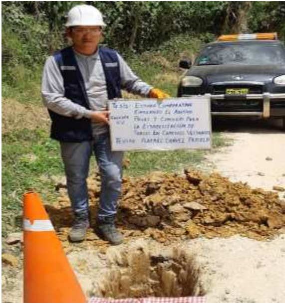
Foto N°5 Excavación de la calicata N°2.
