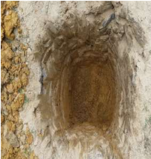
Foto N°7 Calicata N°2, Profundidad 1.50m.
