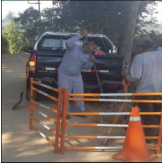
Foto N°1 Excavación de Calicatas con una profundidad de 1.50 m. Fuente: Elaboración Propia
