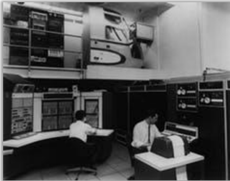
Figura 5: Interfaz ARPANET para el PDP-10 de Xerox
