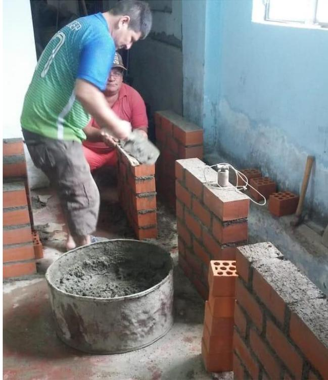
*Figura 19.* Asentado de los muretes con mortero de 5% y 10% de caucho. (Fuente: Elaboración propia)
