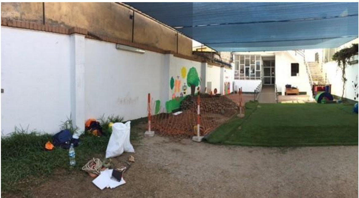
Calicata c-2 – Vista lateral
