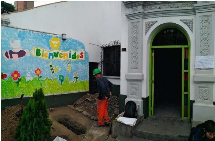
Calicata c-3 ubicada al ingreso del nido
