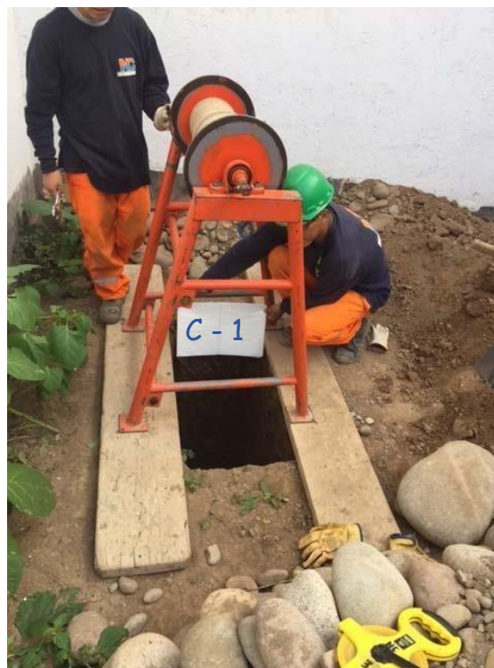
Vista hacia el interior de la calicata c-1. Se aprecia las piedras y bolones extraídas
