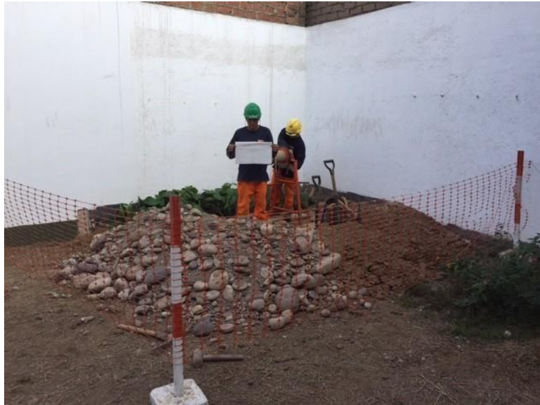
Ubicación de la calicata c-1
