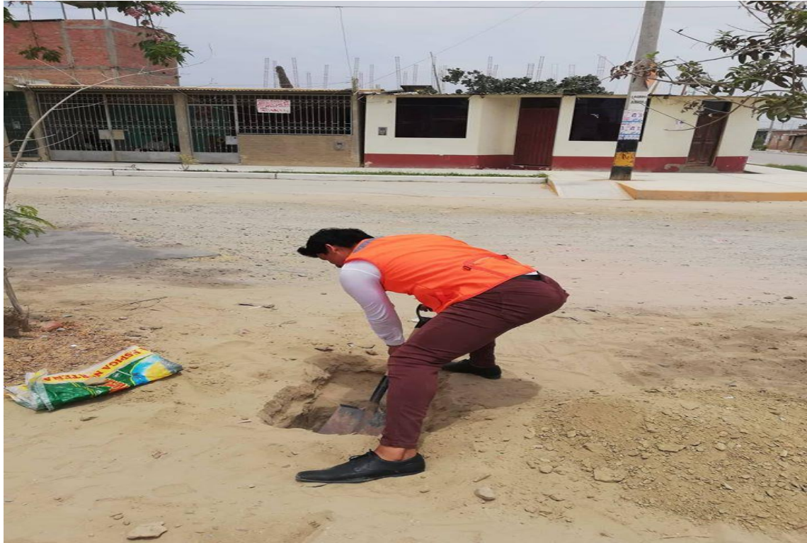
Figura 92: excavación de calicata 01
