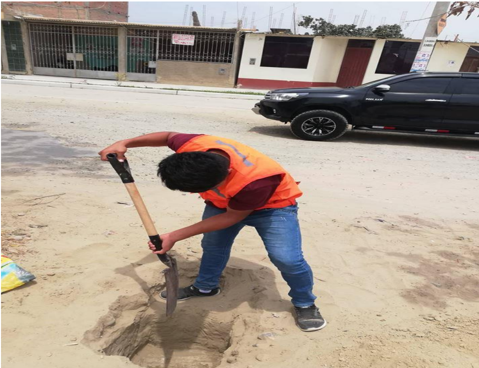
Figura 99: calicata 05 excavación
