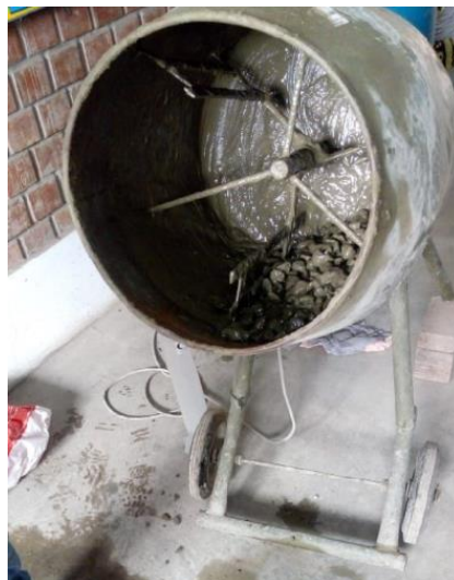
Mezcladora de concreta empleada.
