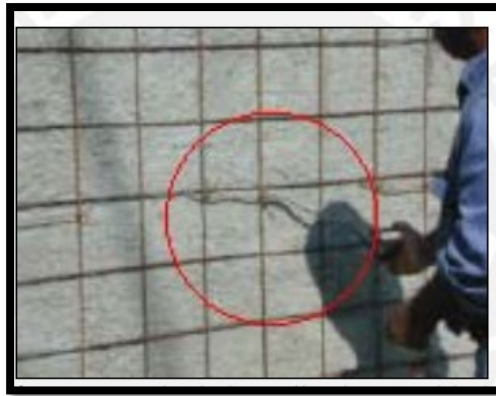
Figura N° 57. Fijado de malla
