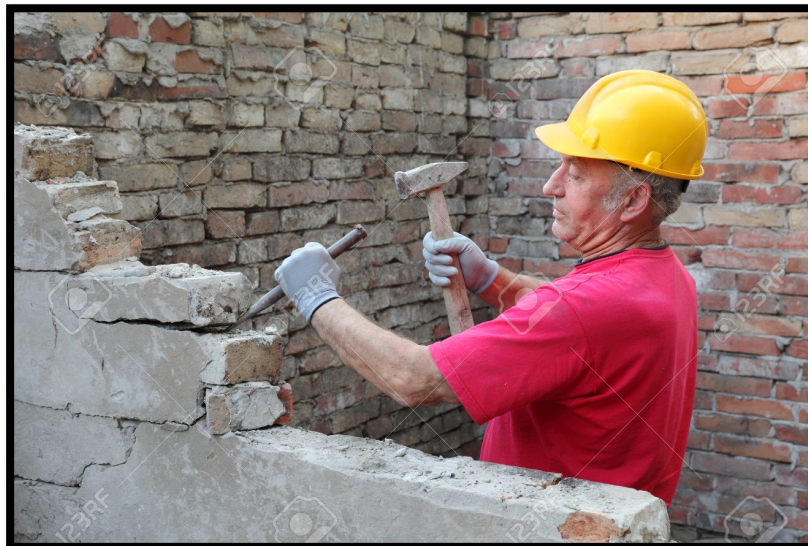
Figura N° 56. Perforación de muro
