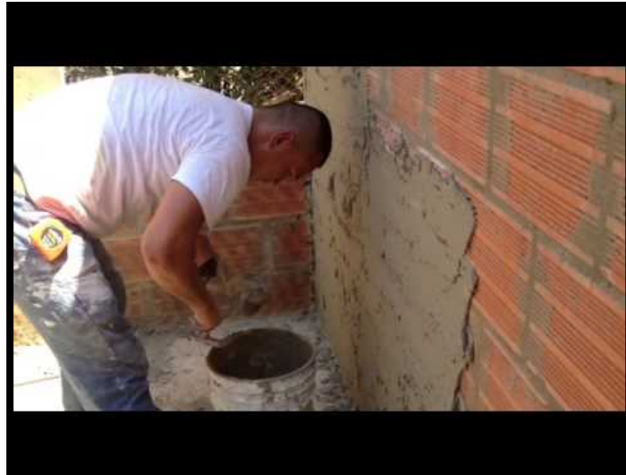
Figura N° 55. Pañeteo de muro
