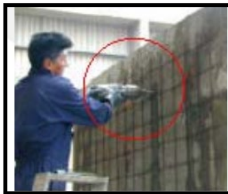
Figura N° 58. Inyección de perforaciones
