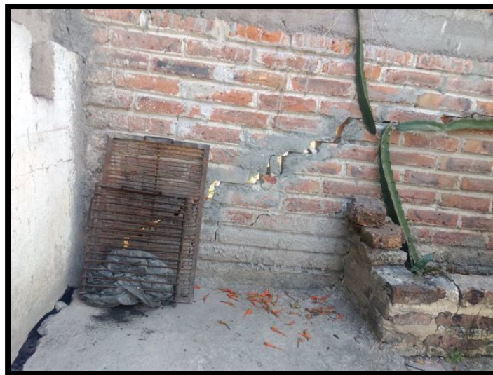
Figura N° 54. Reparación de grietas gruesas
