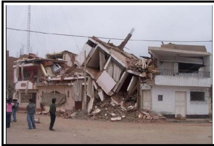
Figura N° 50. Calidad baja de mampostería
