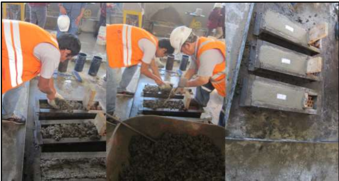
Figura 16. Proceso final de la elaboración de la viga
