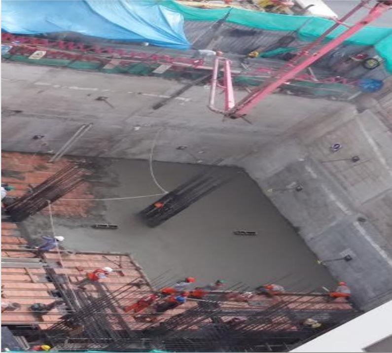
*Figura 5: Vaciado de losa en el sótano 1. Fuente: Propia*
