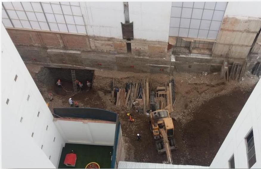
Figura 4: Proceso constructivo de muro pantalla. Fuente: Propia
