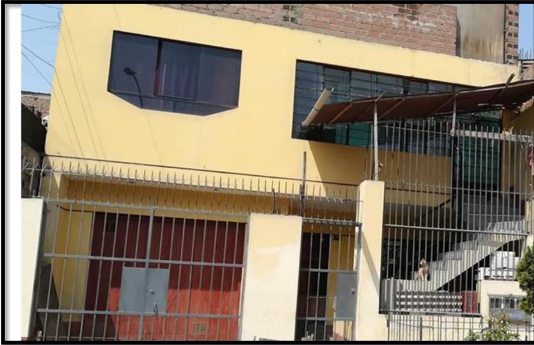
Fig34: Fachada de la segunda vivienda afectada por corrosión.
