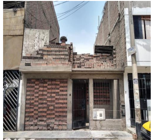
Anexo26: vivienda inspeccionada
