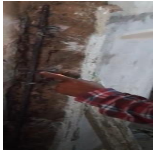
Figura 53. Procedimiento de anclaje con acero (usando el epóxico sikadur 31 para incorporar al concreto a través de los orificios para el anclaje)
