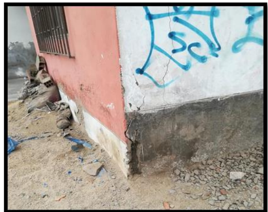
Anexo 18: corrosión grave de acero
