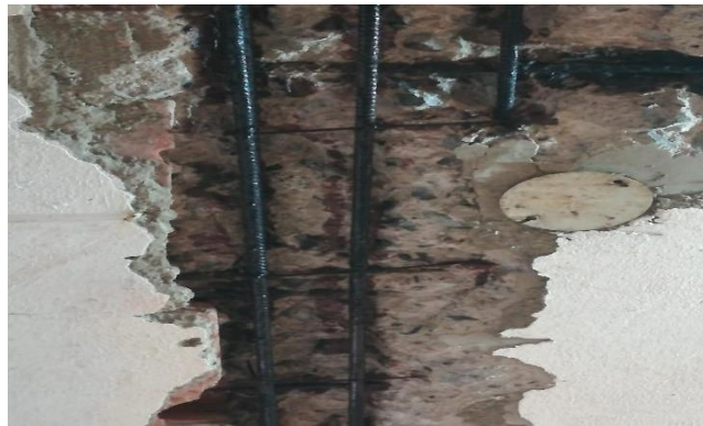
Figura 56: aplicación de transformador de óxido-color negro
