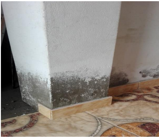
Anexo27: eflorescencia en la columna
