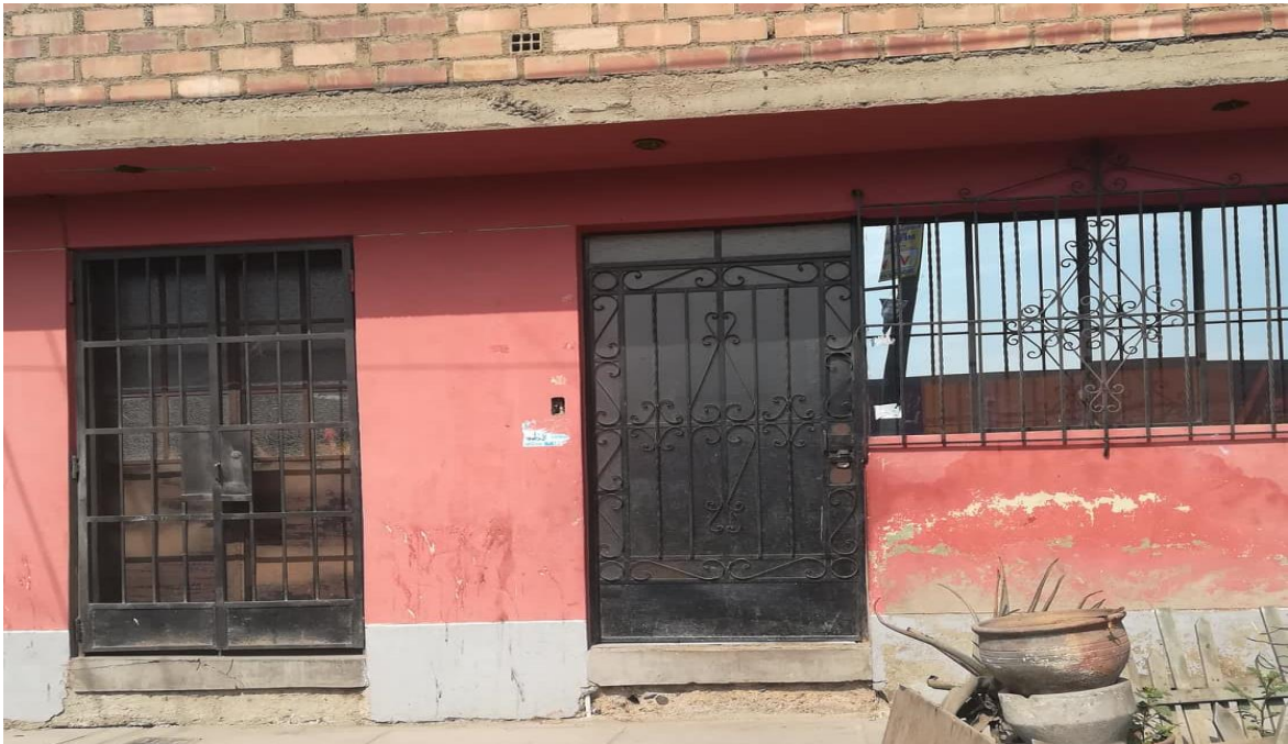
Figura: fachada de la tercera vivienda afectada.
