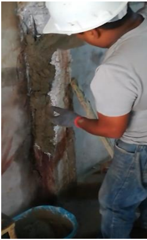
Figura56: Se realiza la mezcla con impermeabilizante para formar el mortero estructural.
