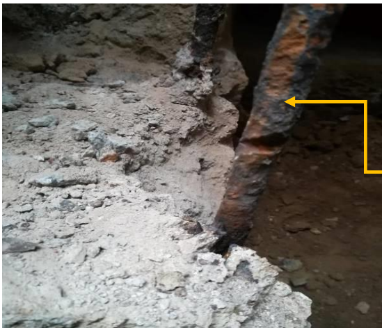
Corrosión en la parte excéntrica de la vivienda
