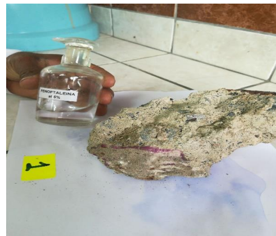
Anexo28: aplicación de fenolftaleína
