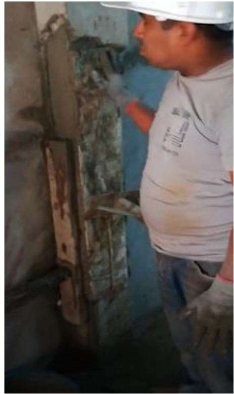
Figura56: Se realiza la mezcla con impermeabilizante para formar el mortero estructural.
