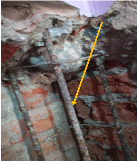
Corrosión en la parte excéntrica de la vivienda
