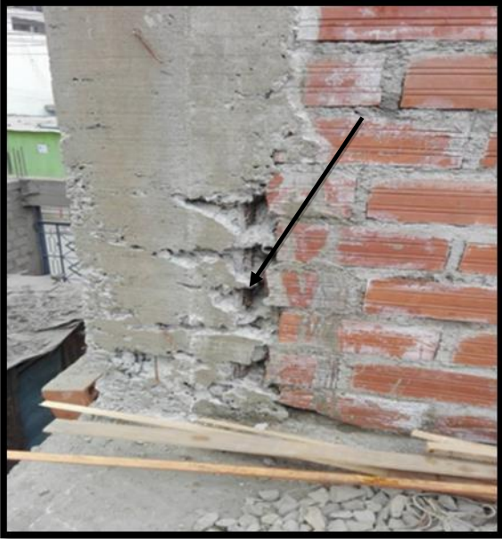
Cangrejas dando da a indicar un mal diseño de mezclas.
