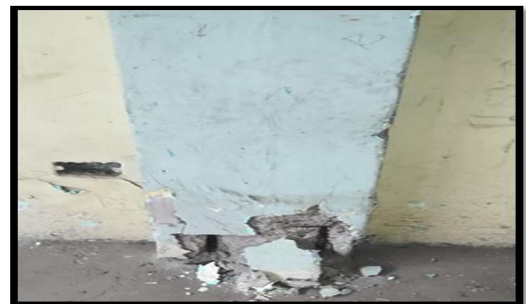
Anexo 24: corrosión grave de acero.
