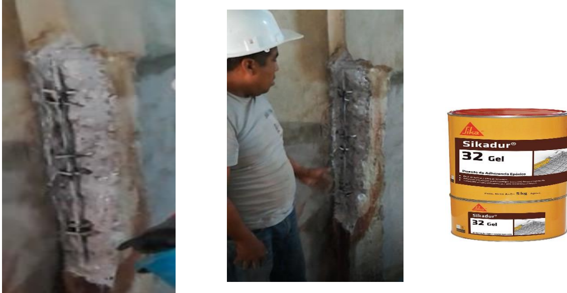
Figura 55. Unión de concreto antiguo con concreto nuevo (Sika Dur 32)
