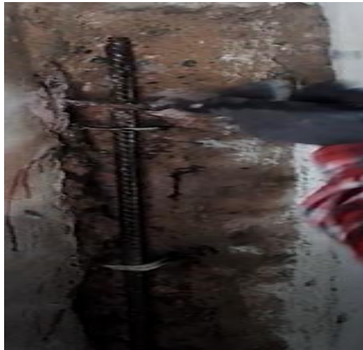
Figura 53. Procedimiento de anclaje con acero (usando el epóxico sikadur 31 para incorporar al concreto a través de los orificios para el anclaje)
