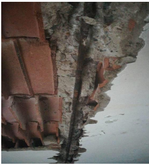
Corrosión en la viga de apoyo de la escalera
