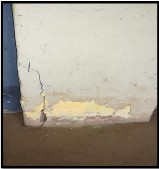
Anexo 23: corrosión grave de acero.
