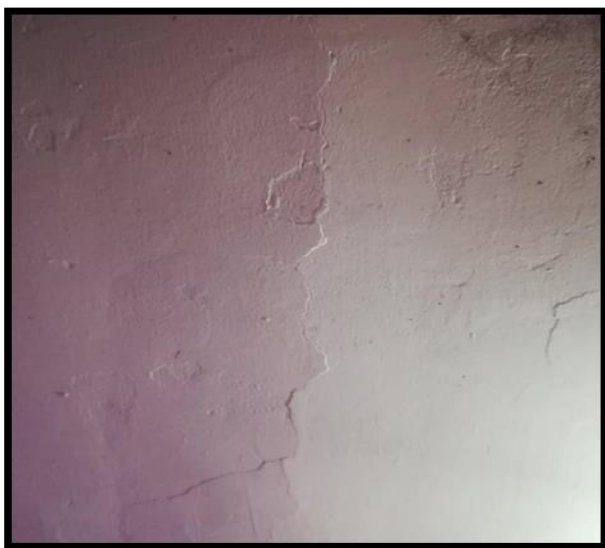
Anexo 19: corrosión grave de acero.
