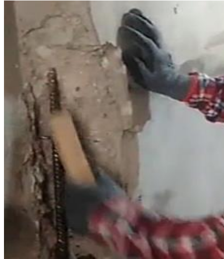
Figura54: limpieza del acero corroído
