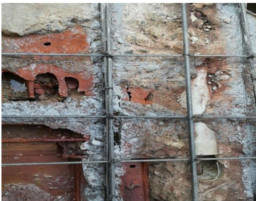
Figura 57: aplicación de epòxico y mortero estructural.
