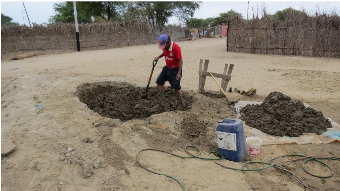
Figura 5. Trabajos de labrado con masa de adobe convencional.
