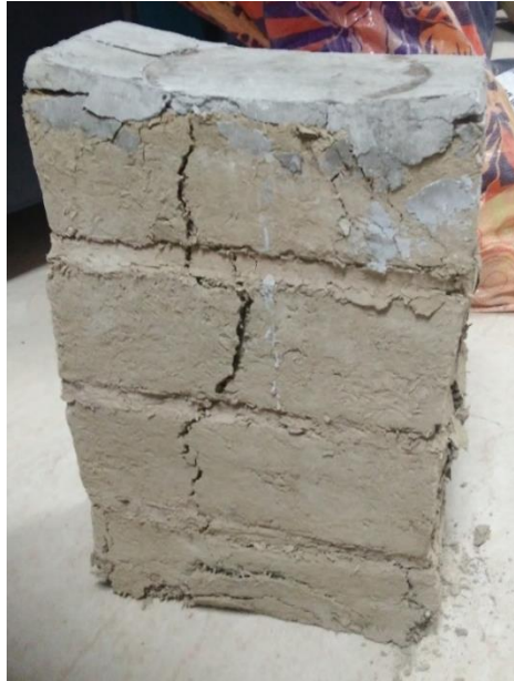
Figura 23. Murete de adobe convencional después del ensayo a compresión.
