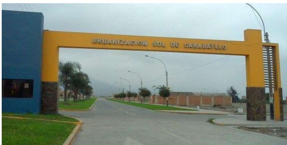
Figura 36. Urbanización Sol de Carabayllo
