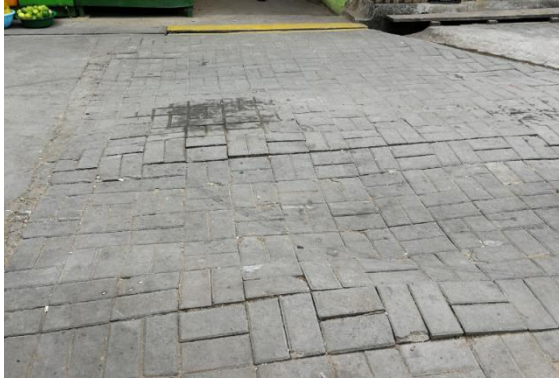
Fotografías 07: Las aceras dentro del mercado se encuentran deforme.
