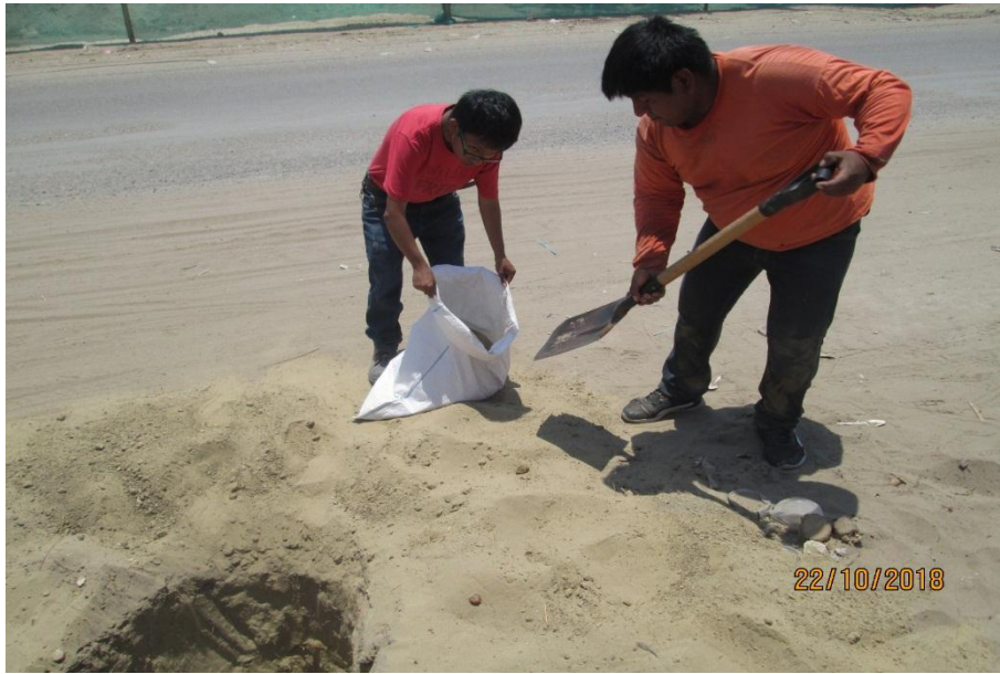
Fotografía 94. Excavación de la calicata 2, profundidad 1.50 m
