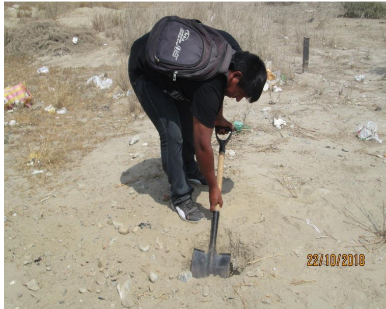
Fotografía 98. Excavación de la calicata 4, profundidad 1.50 m
