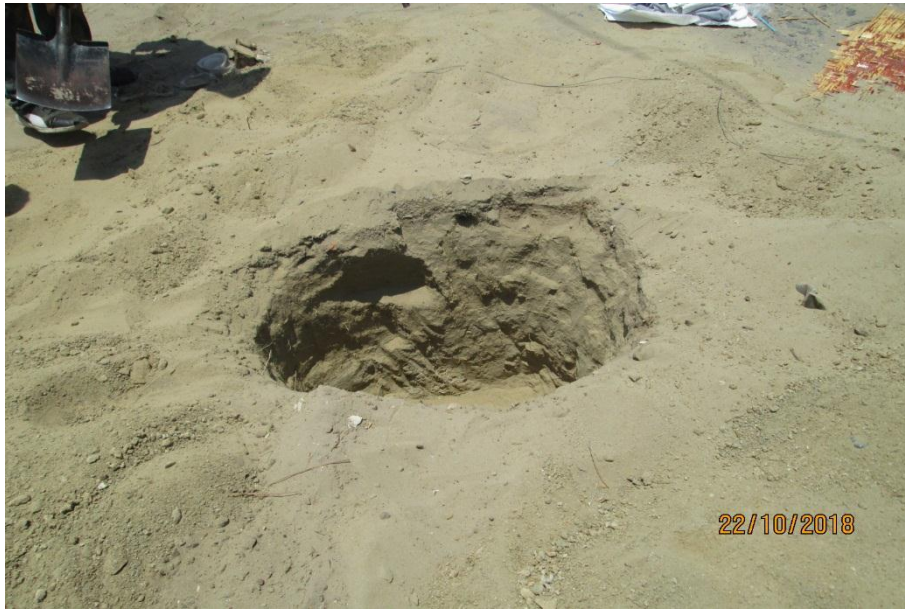
Fotografía 96. Excavación de la calicata 3, profundidad 1.50 m
