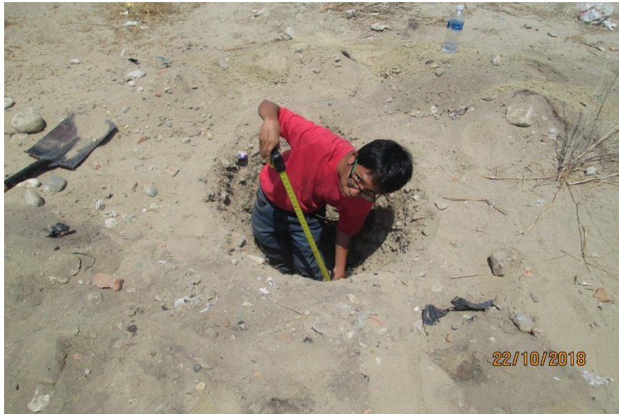
Fotografía 92. Excavación de la calicata 1, profundidad 1.50 m
