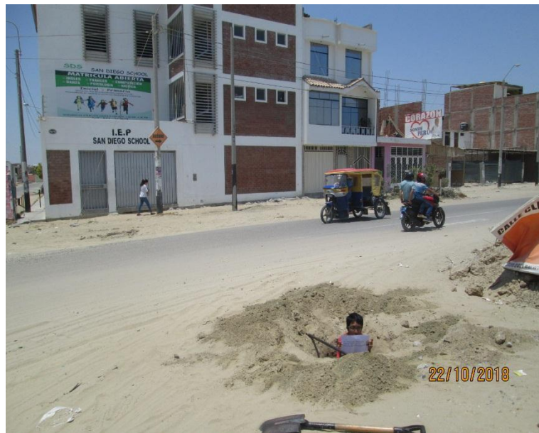
Fotografía 100. Excavación de la calicata 5, profundidad 1.50 m
