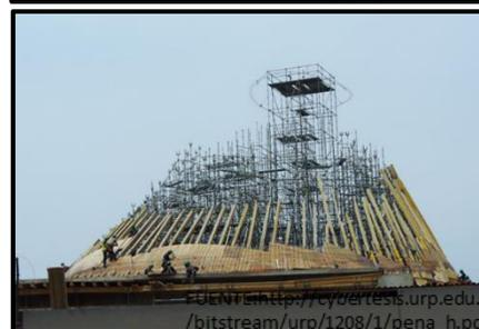
**ESTRUCTURA PORTANTE DE CARGAS:** La estructura portante consiste en muros de concreto armado. Los muros adyacentes a la estructura del cono tienen como función no sólo resistir cargas de gravedad, sino también el empuje lateral ejercido por las fuerzas que provienen del cono. Todos estos muros también están preparados para soportar las fuerzas sísmicas que eventualmente se producirán en su zona de ubicación.
