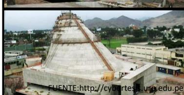
El sistema constructivo es aporticado con vigas y columnas de concreto armado, los techos son aligerados con tabiquería interior de ladrillo, la bóveda principal de la iglesia es de concreto armado, el sistema estructural de los sótanos es con muros de contención y lozas de concreto armado.
