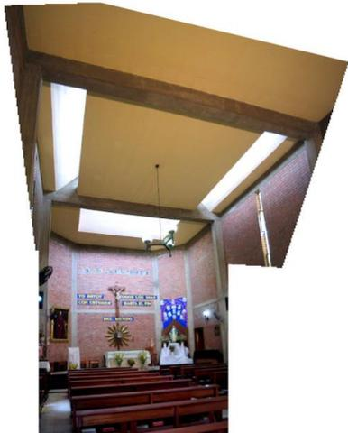
El sistema constructivo es aporticado con vigas y columnas de concreto armado, los techos son aligerados con tabiquería interior de ladrillo.
