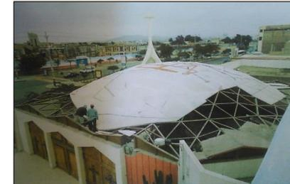
**ASPECTO TECNOLÓGICO:** El asoleamiento se da por la parte superior de los muros donde se ubican los vanos de forma triangular, que se encargaron de lograr que la cobertura se una a la demás estructura de la nave central, la ventilación no se da de manera correcta, pues al ser de escala pequeña, en su interior se siente un ambiente cálido.
