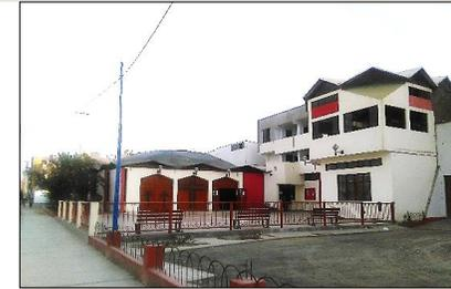
**ASPECTO CONSTRUCTIVO:** La Parroquia Sagrado Corazón de Jesús cuenta con un sistema constructivo, aporticado, con vigas y columnas de concreto, y para la iglesia además, usaron un techo de estructura liviana con lo que logró darle una forma novedosa a la nave central.
