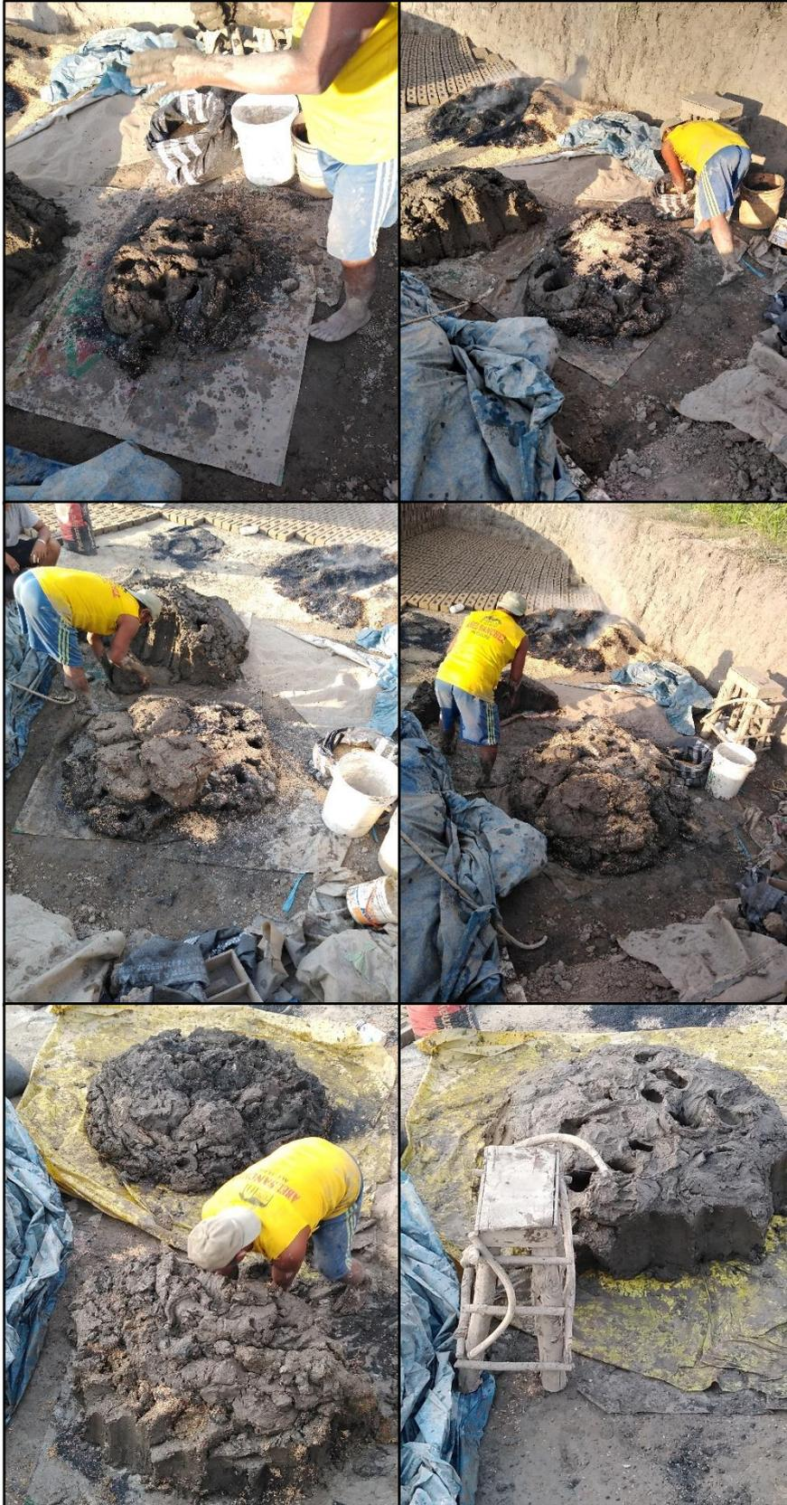
**FOTO N° 06:** Mezcla de arcilla incorporándole cascara de arroz, ceniza de cascara de arroz y cemento
