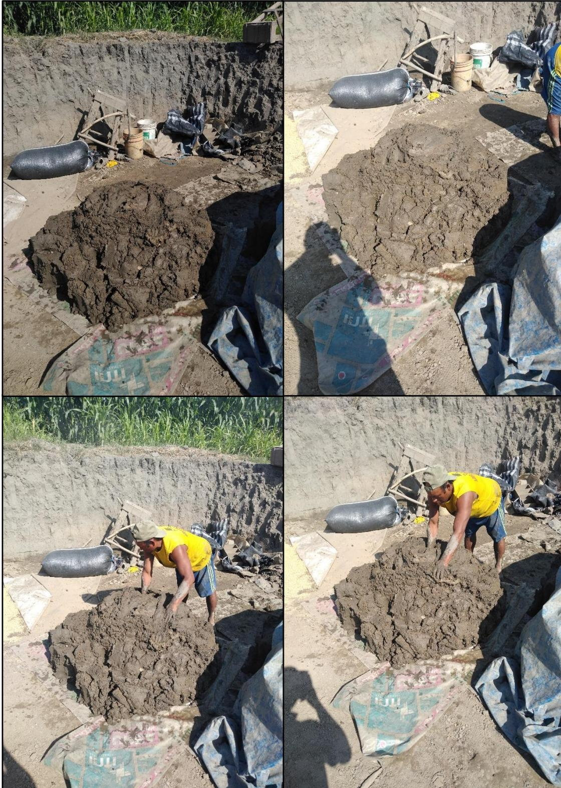
**FOTO N° 05:** Preparación de la mezcla de arcilla
