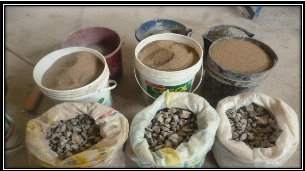
FOTO N° 22: El material ya pesado para realizar la mezcla con residuos de concreto como agregado grueso.
