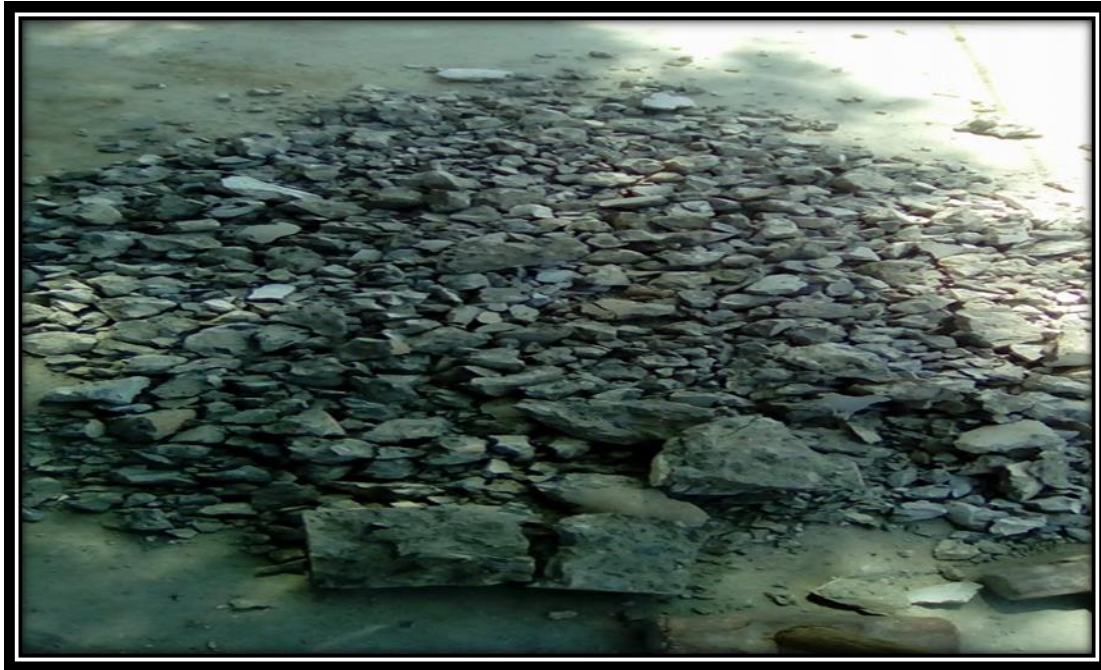
FOTO N° 01: Se recolecto residuos de concreto estructural, para luego ser triturados.
