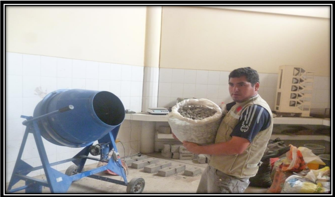
FOTO N° 23: Colocando el agregado grueso de residuo de concreto en la mezcladora para realizar las probetas.
