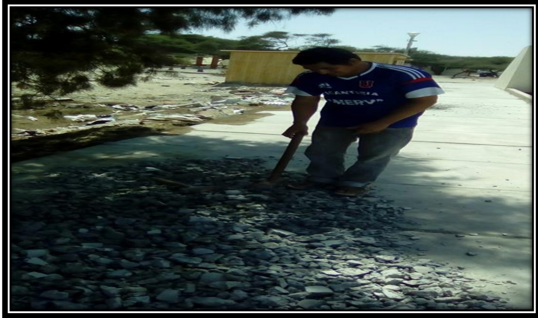
FOTO N° 03: Demolición para poder alcanzar la granulometría necesaria para el agregado grueso que será sustituido en el proyecto.
