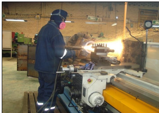
Figura 23 Técnico con EPP completo para metalizar Fuente: Instalaciones de Ipsycom Ingenieros SAC
