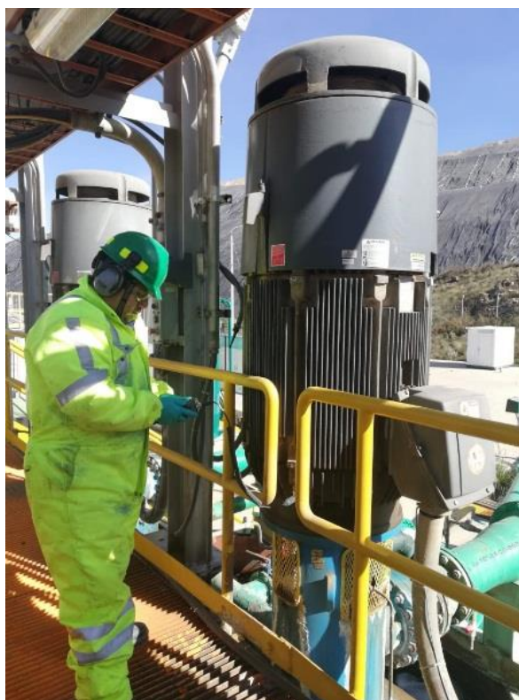
Figura 15 Análisis vibracional de motor eléctrico Fuente: Ipsycom Ingenieros SAC
