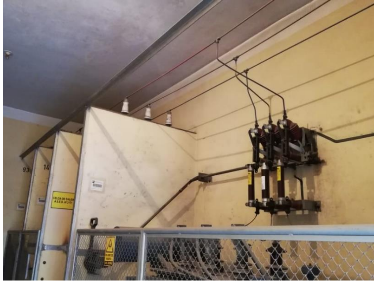
FIGURA 18 Seccionador electromecánico para media tensión
