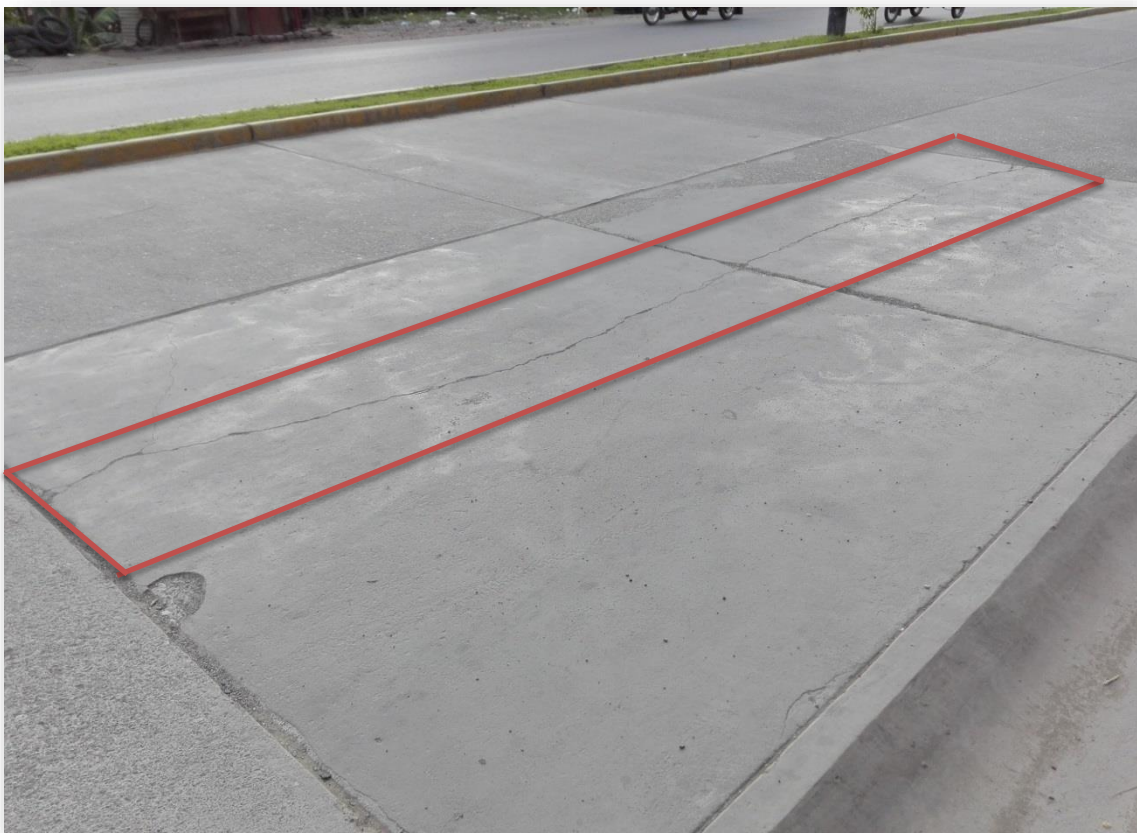
Imagen 7 : Fisura Longitudinal
