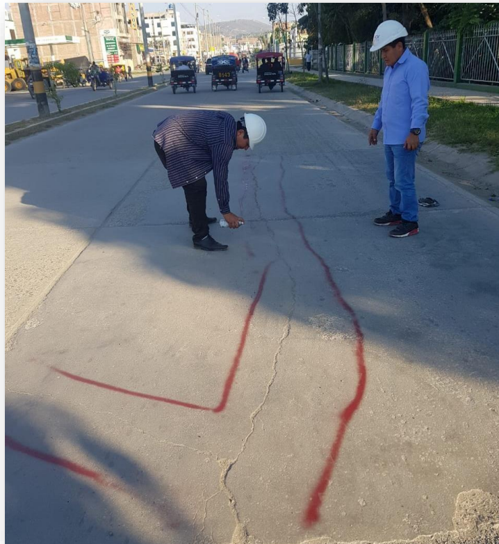
Imagen 2654 : Fisura Longitudinal
