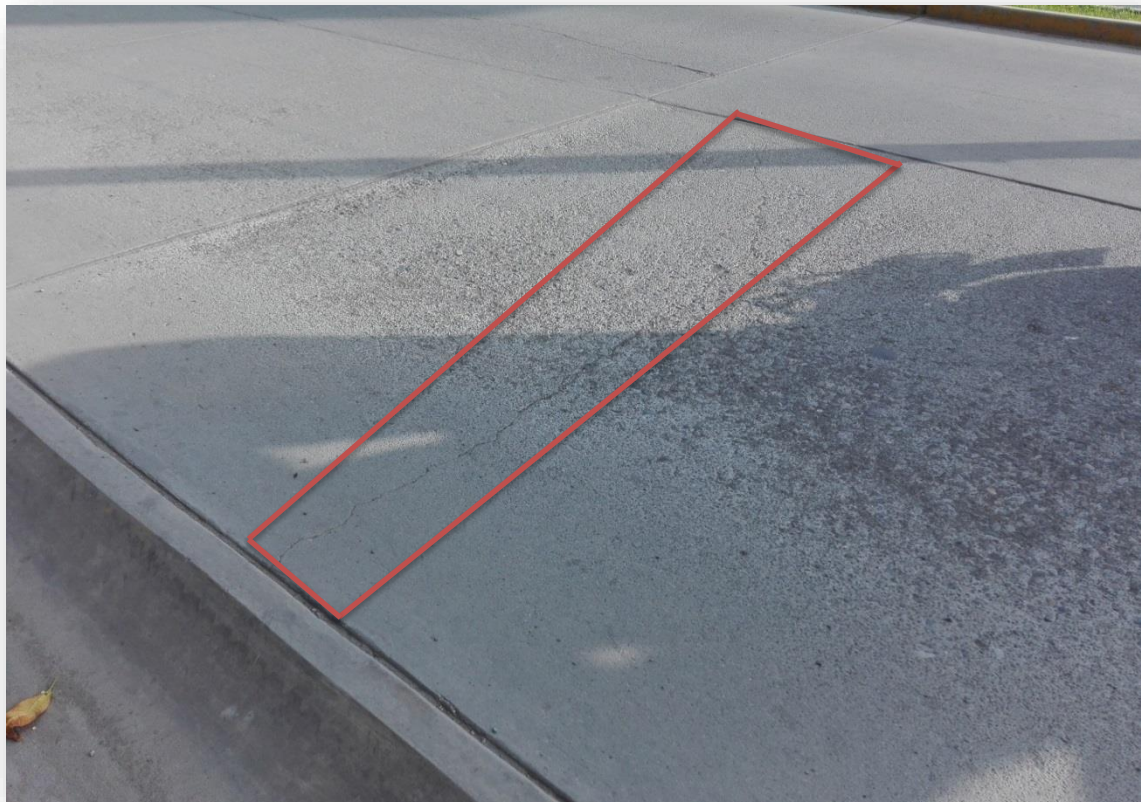
Imagen 8 : Fisura Transversal
