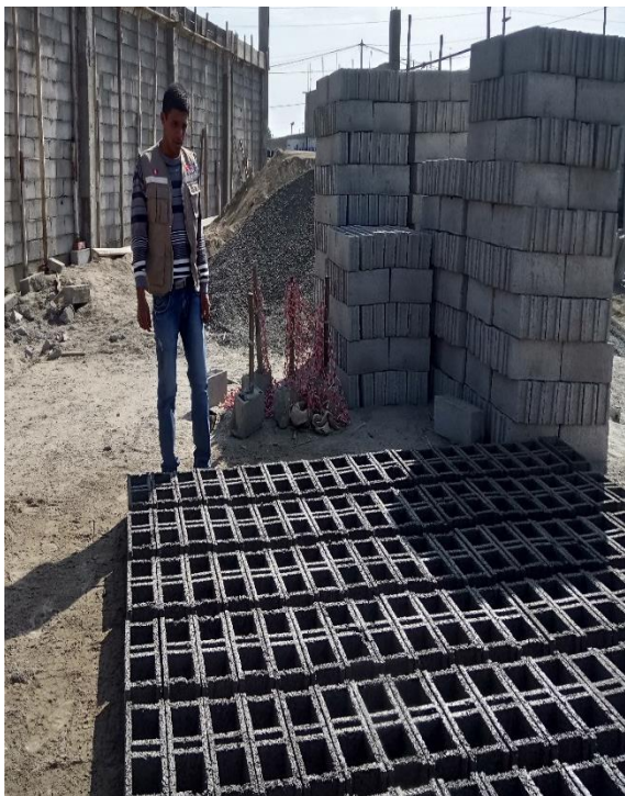
Figura 07: Elaboración del bloque de concreto
