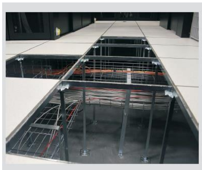
Figura 13. Piso técnico
