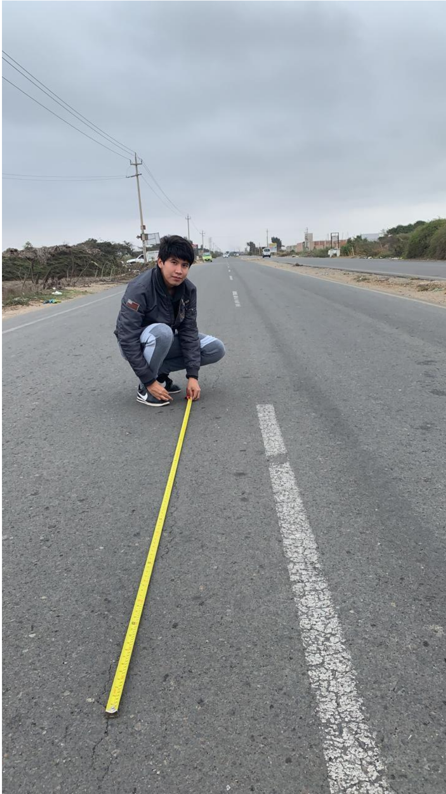
Figura 13. Medición de falla grieta longitudinal
