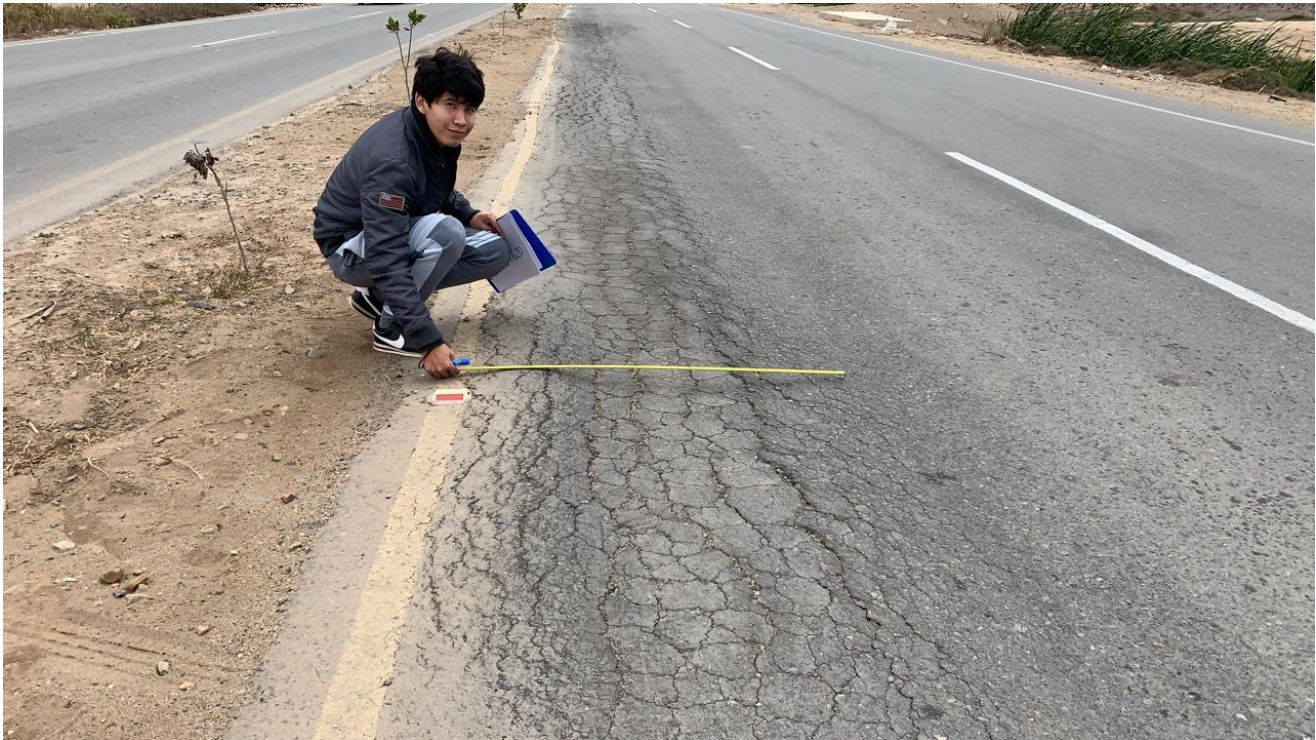
Figura 31. Medición de falla piel de cocodrilo
