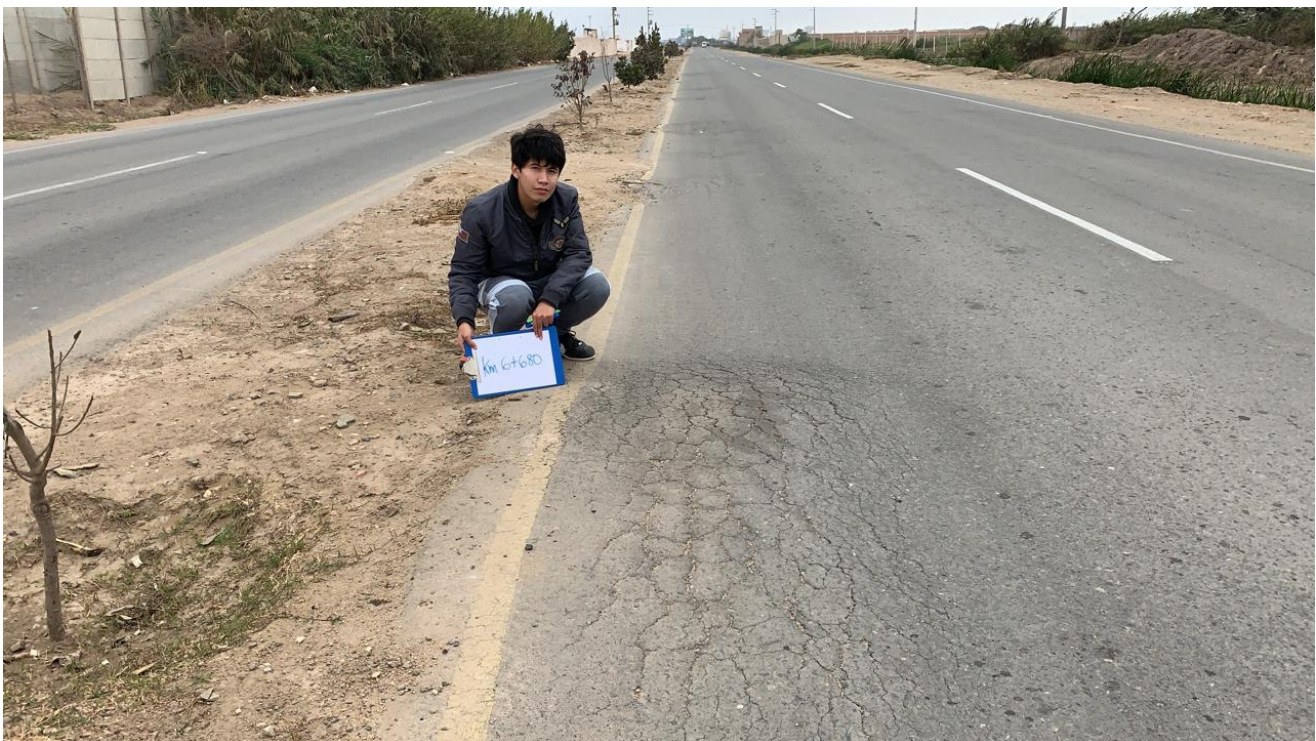
Figura 31. Medición de falla piel de cocodrilo
